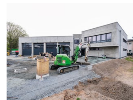
Der Rohbau ist fertig gestellt, die Arbeiten für die Erstellung des Parkplatzes mit Versickerungsanlagen sind noch in vollem Gange.
