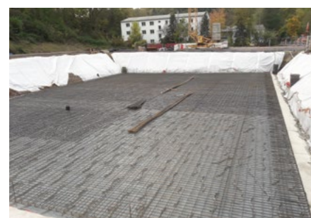
Verlegung der Sohlplattenbewehrung
