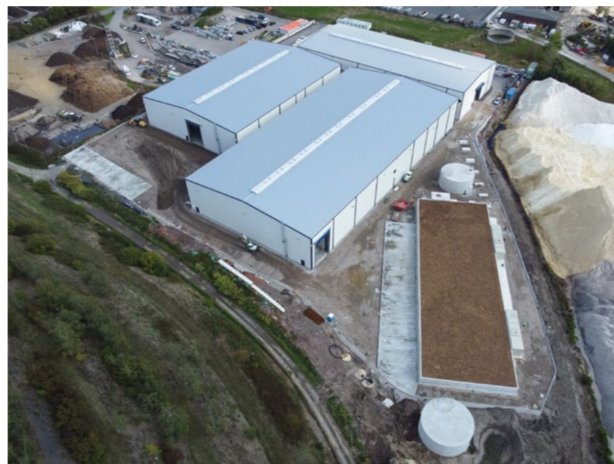
Eindrucksvolle Drohnenaufnahme der drei Hallen und der Biofilteranlage (rechts)
