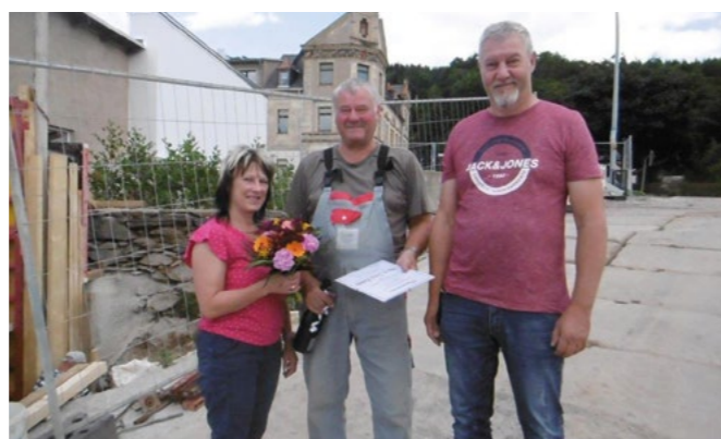
Auf der Hochwasserschutz-Baustelle in Olbernhau wurde der Baufacharbeiter Jenz Klemm in den Ruhestand verabschiedet.
