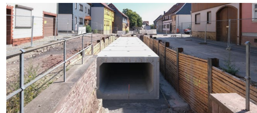
Sieben der insgesamt neun Stahlbeton-Rahmenbaufertigteile sind eingesetzt.
