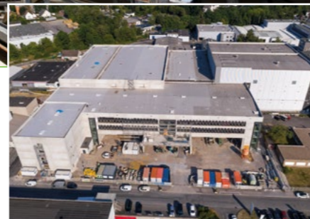
Gesamtansicht nach Fertigstellung der Lager-Rohbauten
