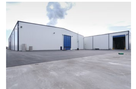
Außenansicht der fertig gestellten In- und Outputhalle
