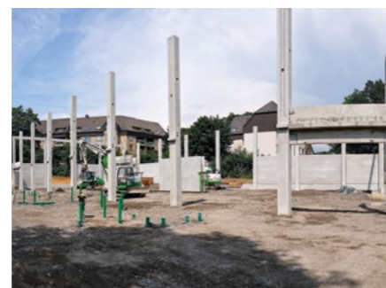
Bereits bei der Fertigteilmontage lässt sich die Größe der Halle erahnen.
