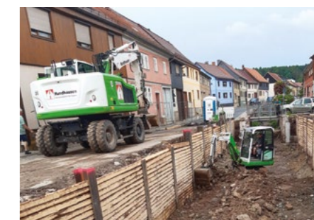
Herstellung der Gründungssohle
