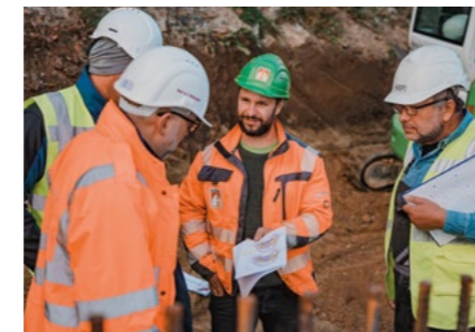
Johannes Schmiedel bei der wöchentlichen Baubegehung
