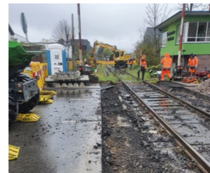
Die Gleisbau-Kolonnen sind mit dem Rückbau des Gleises beschäftigt.
