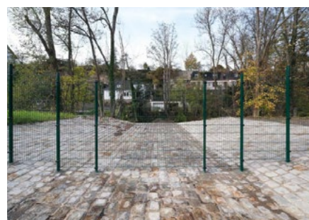
Trichter-Notüberlauf des Regenrückhaltebeckens
