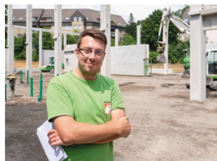
Florian Schreiber ist mit der Leistung der Tiefbauarbeiten sehr zufrieden.
