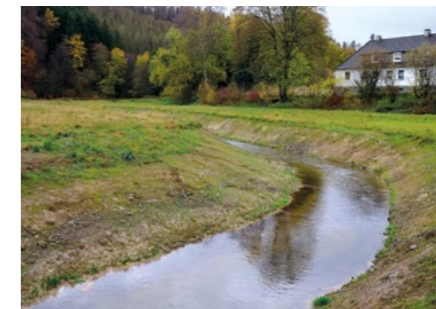
Nach Umlegung der Gewässer
