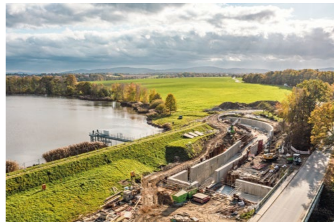
Anspruchsvolle Hochwasserentlastungsanlage in Göda, Seite 7
