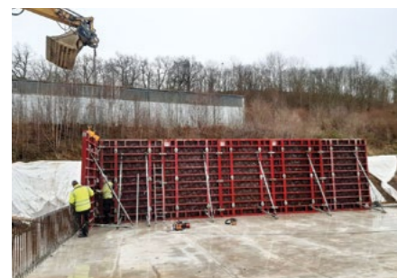
Aufstellung der Wand-Schalung
