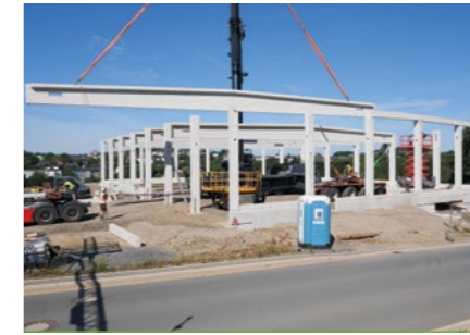
Montage der Spannbetonbinder für das neue Verwaltungs- und Lagergebäude in Lüdenscheid.
