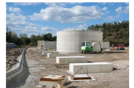
Fundamentarbeiten im Außenbereich, im Hintergrund ist ein Regenrückhaltebecken erkennbar.
