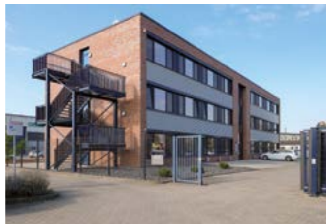
Neubau eines Verwaltungsgebäudes für Remondis in Prützke Seite 14
