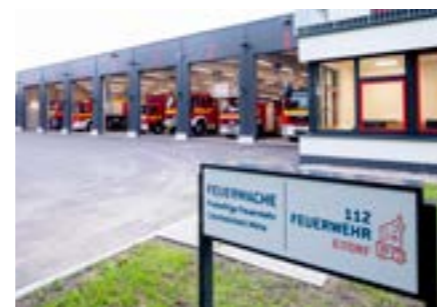
Die neue Feuerwache erfüllt nun alle Anforderungen an den Brandschutzbedarf
