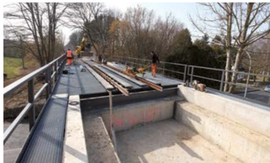
Montage des Gleises auf einer neuen Brücke
