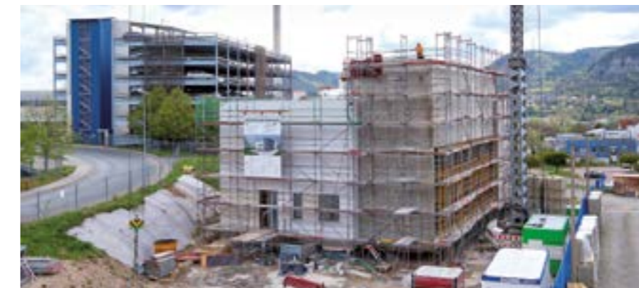
Der Rohbau des neuen Umspannwerkes ist fast fertiggestellt.
