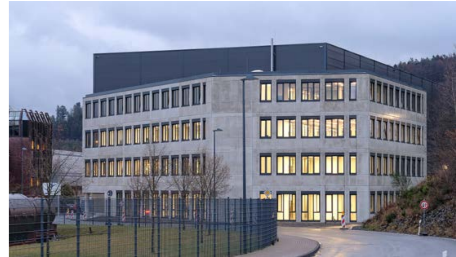
Blick auf das moderne markante Büro- und Sozialgebäude
