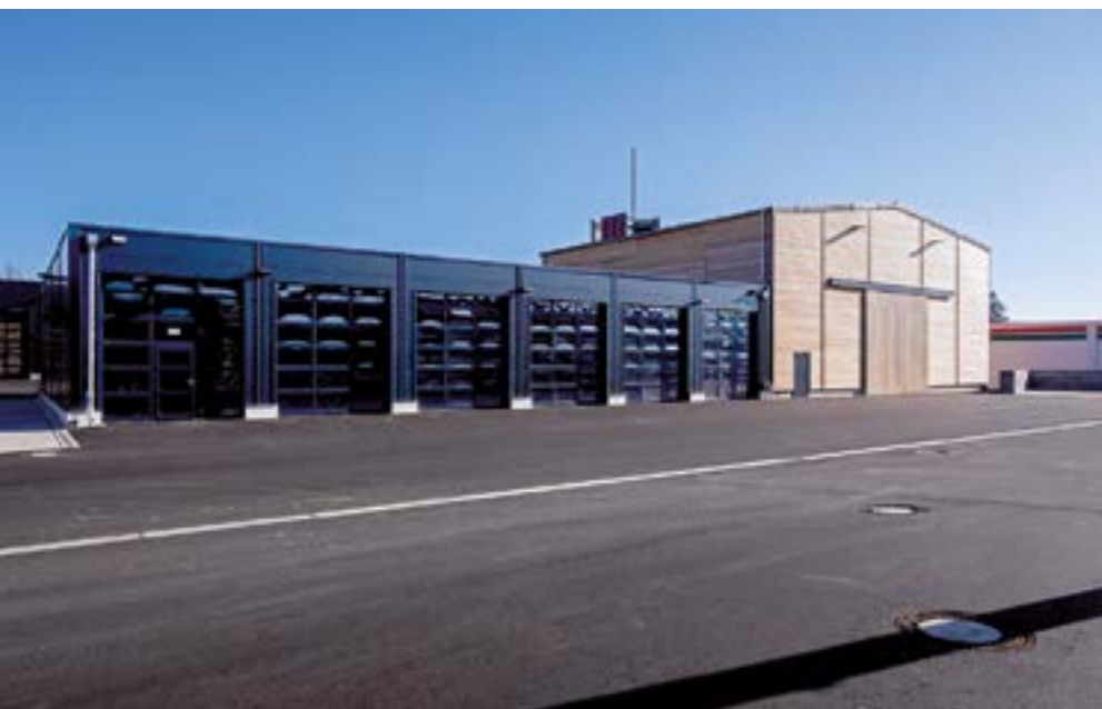
Fahrzeug- und Salzlagerhalle in Holzbauweise
