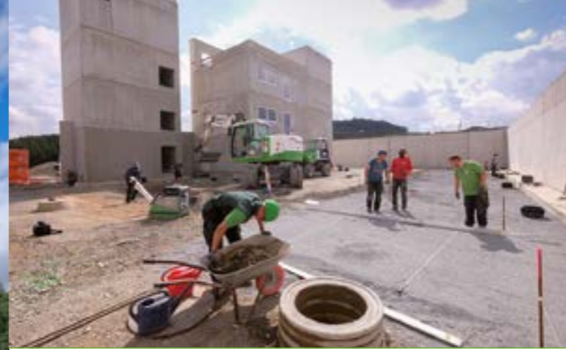
(v. l.) Houssein Omar, Alexander Henkl, Henry Hupertz, Meik Stauf, Souleymane Toure, Justin Herden. Die Tiefbau-Kolonne bereitet das Feinplanum für die Übungshalle vor.
