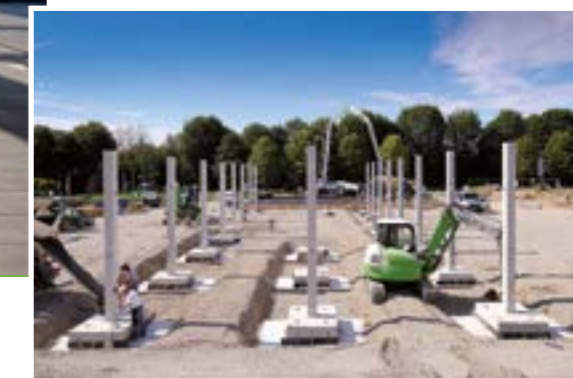
Montage der Stahlbetonstützen
