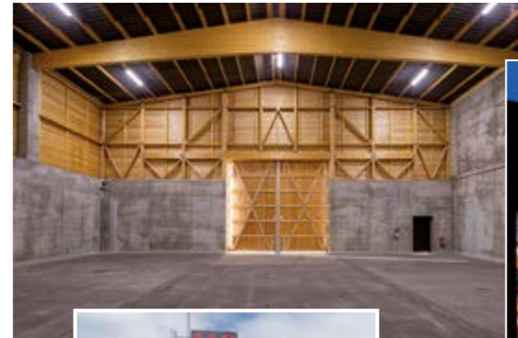
Kombination von Beton- und Holz für eine sorgfältige Salzlagerung
