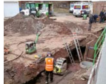
Maurice Petzold, Auszubildender 1. Lehrjahr, beim Verdichten mit Hilfe der Rüttelplatte
