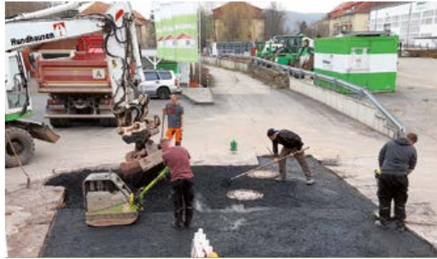
Der Einbau der Asphalt-Tragschicht erfolgt im Einfahrtbereich des Bauhofs (v. l.) Siegmar Scheffel, Andre Braun, Thomas Rödiger, Sascha Radloff
