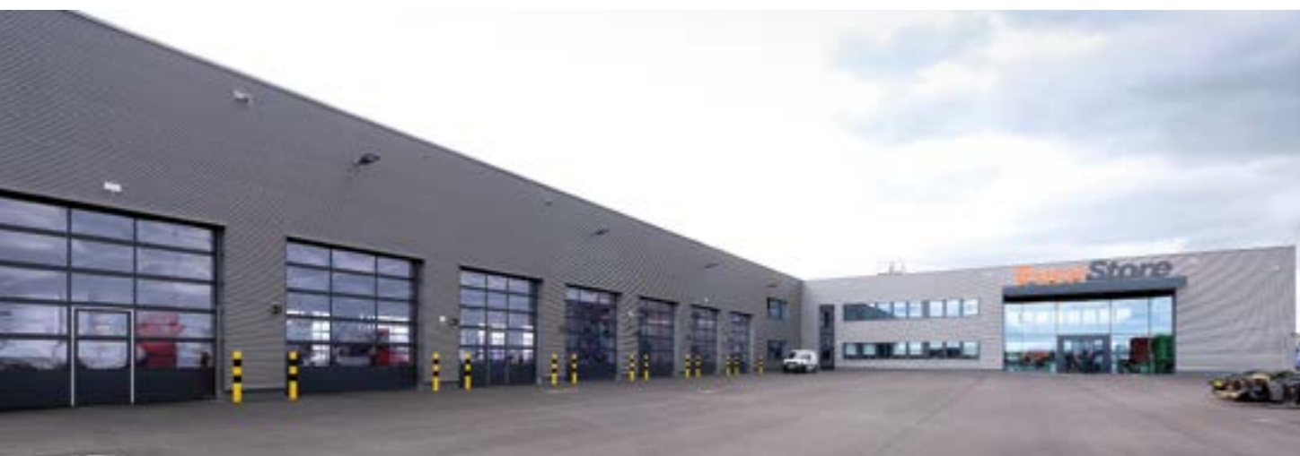
Blick auf den Haupteingang und die Fahrzeuginstandsetzungshalle
