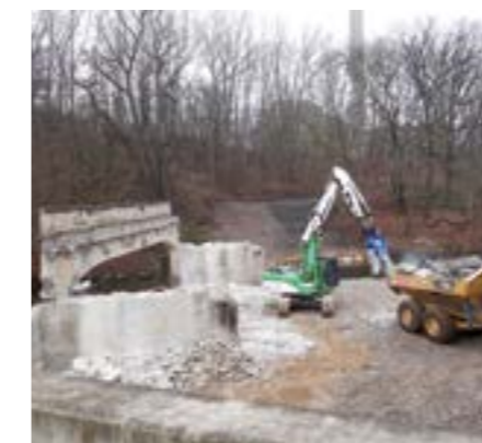
Die Abbrucharbeiten der Brücke sind in vollem Gange.
