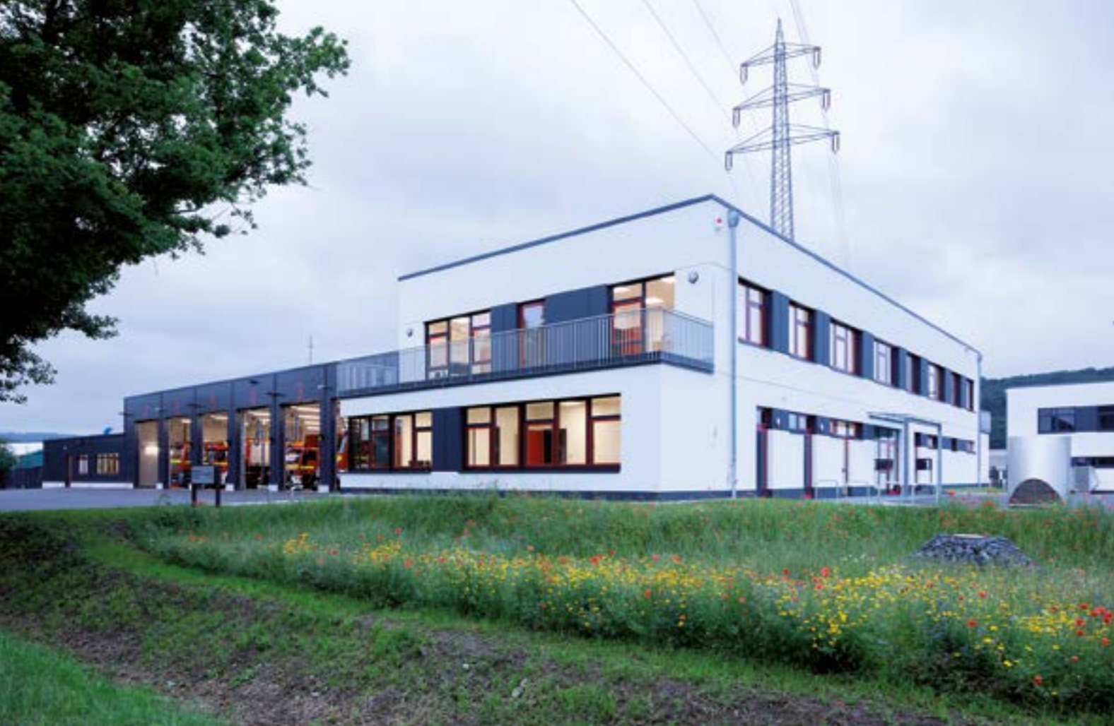
Neubau der Feuerwache mit angegliederter Fahrzeughalle
