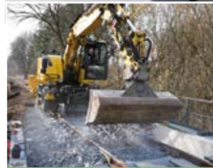
Karsten Gräbener beim Einschottern des neuen Gleises
