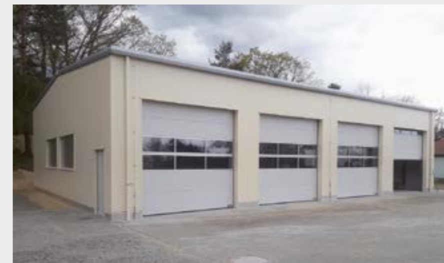
Fahrzeughalle für vier Fahrzeuge des Katastrophenschutzes
