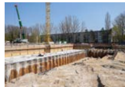
Baugrube mit Spundwandverbau
