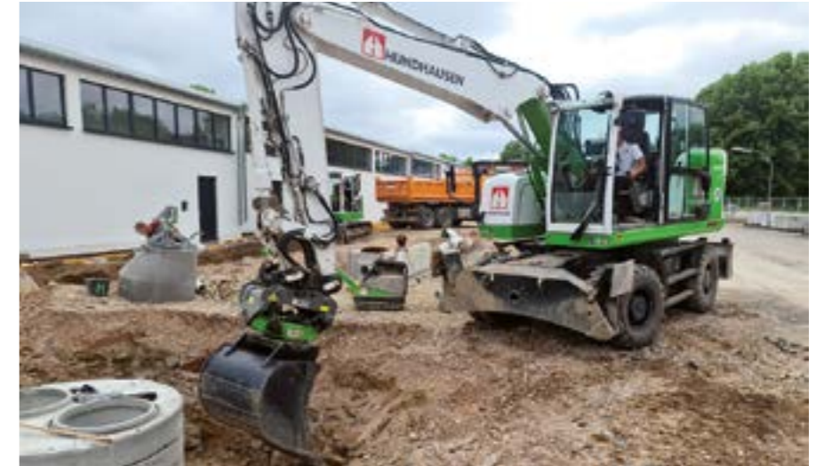
Julian Rödiger mit dem CAT 317 bei Tiefbau-Arbeiten auf dem Gelände des Bauhofs der Stadt Sontra
