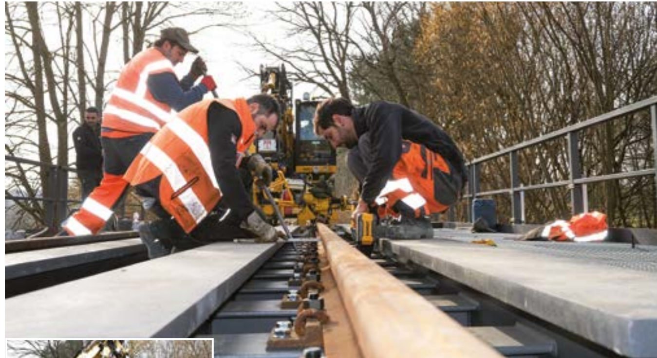
Die Gleisbau-Kolonne beim Einstellen der Spurweite
