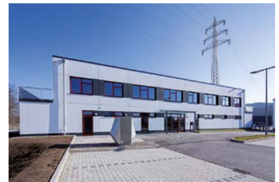
Großzügige Außenflächen vor dem neuen Feuerwehrhaus
