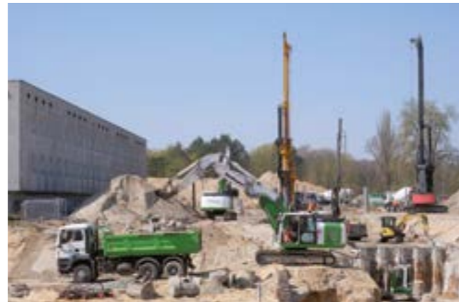
Neubau von Depots und Werkstätten für die Berliner Museen Seite 12
