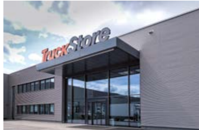
Neubau von Werkstätten, Büros und Waschhallen in Erfurt Seite 10-11
