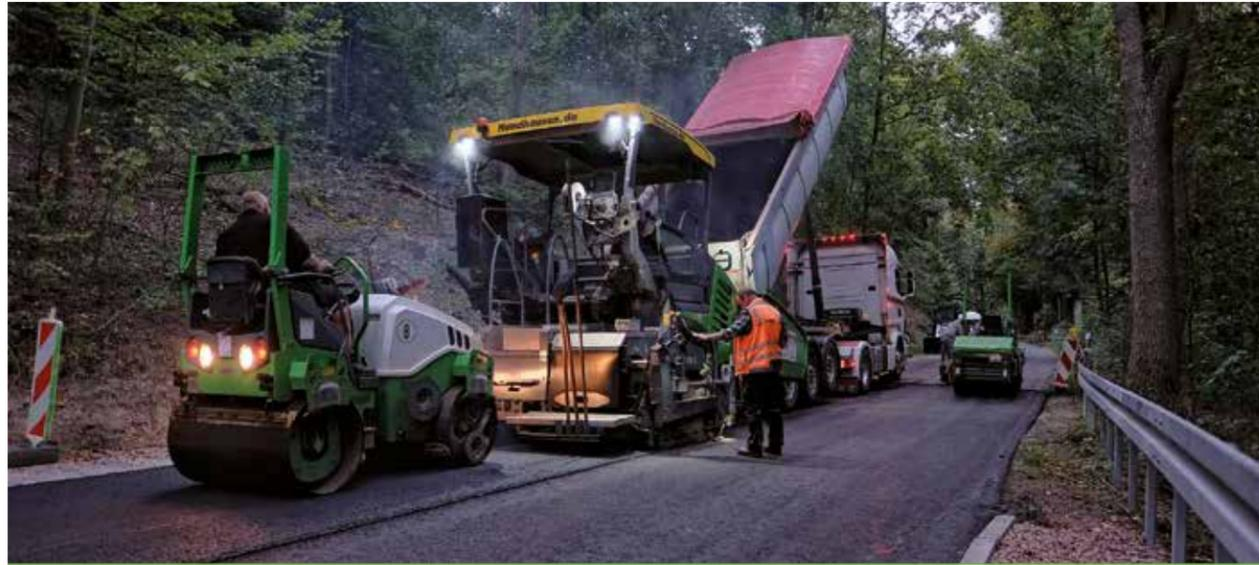
Halbseitiger Einbau der Asphaltbetondeckschicht AC 11: (v. l.) Torsten Hein auf der Walze und Siegmars Scheffel an der Fertigerbohle
