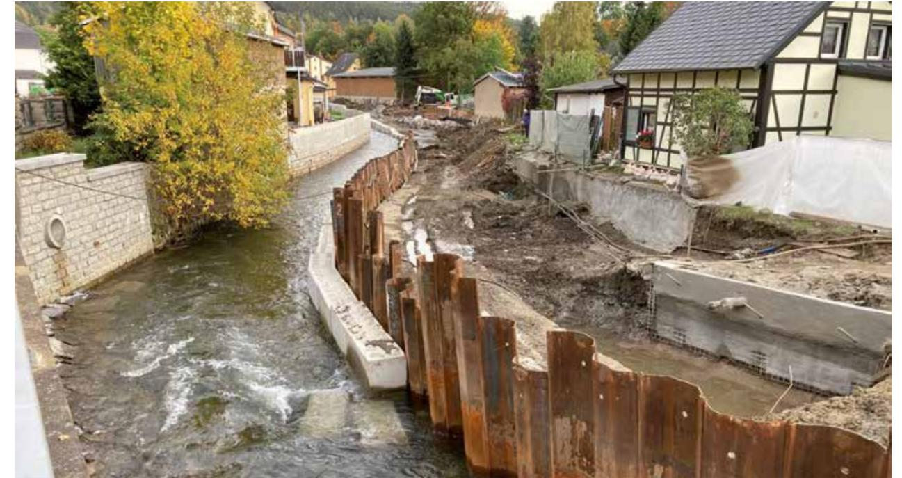
Herstellung der Baugrube für die zukünftige Hochwasserschutzwand. Der Bodenaushub, der Spritzbeton und die Rückverankerung der Spritzbetonschale können nur abschnittsweise im Wechsel erfolgen, um das am Gewässer stehende Fachwerkhaus zu schützen.
