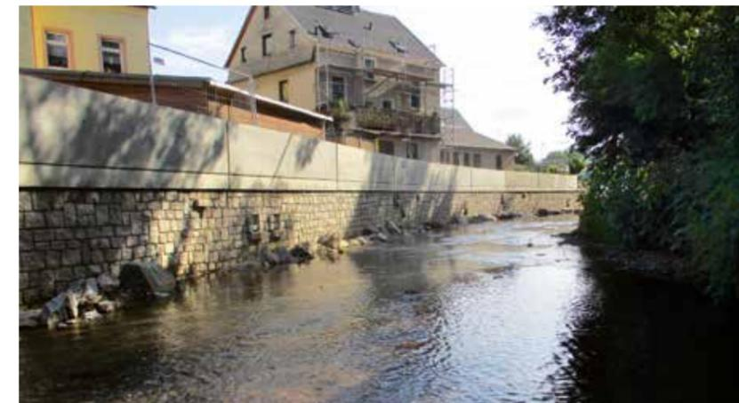
Rückverankerte Hochwasserschutzwand mit Natursteinverblendung aus unregelmäßigem Schichtenmauerwerk aus grauem Granit
