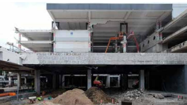
Der erste Teilabriss ist erfolgt, im Hintergrund werden gerade die provisorischen Stahl-Abfangkonstruktionen zur Sicherung des Bestands eingebaut.
