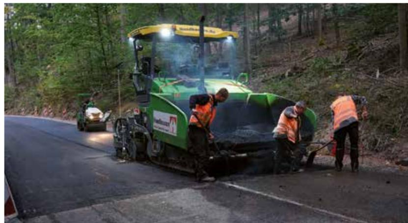
Die Asphaltbetondeckschicht wird an die Bestandsfahrbahn angeschlossen. (v. l.) Paul Hameister, Bodo Schröder und Siegmars Scheffel
