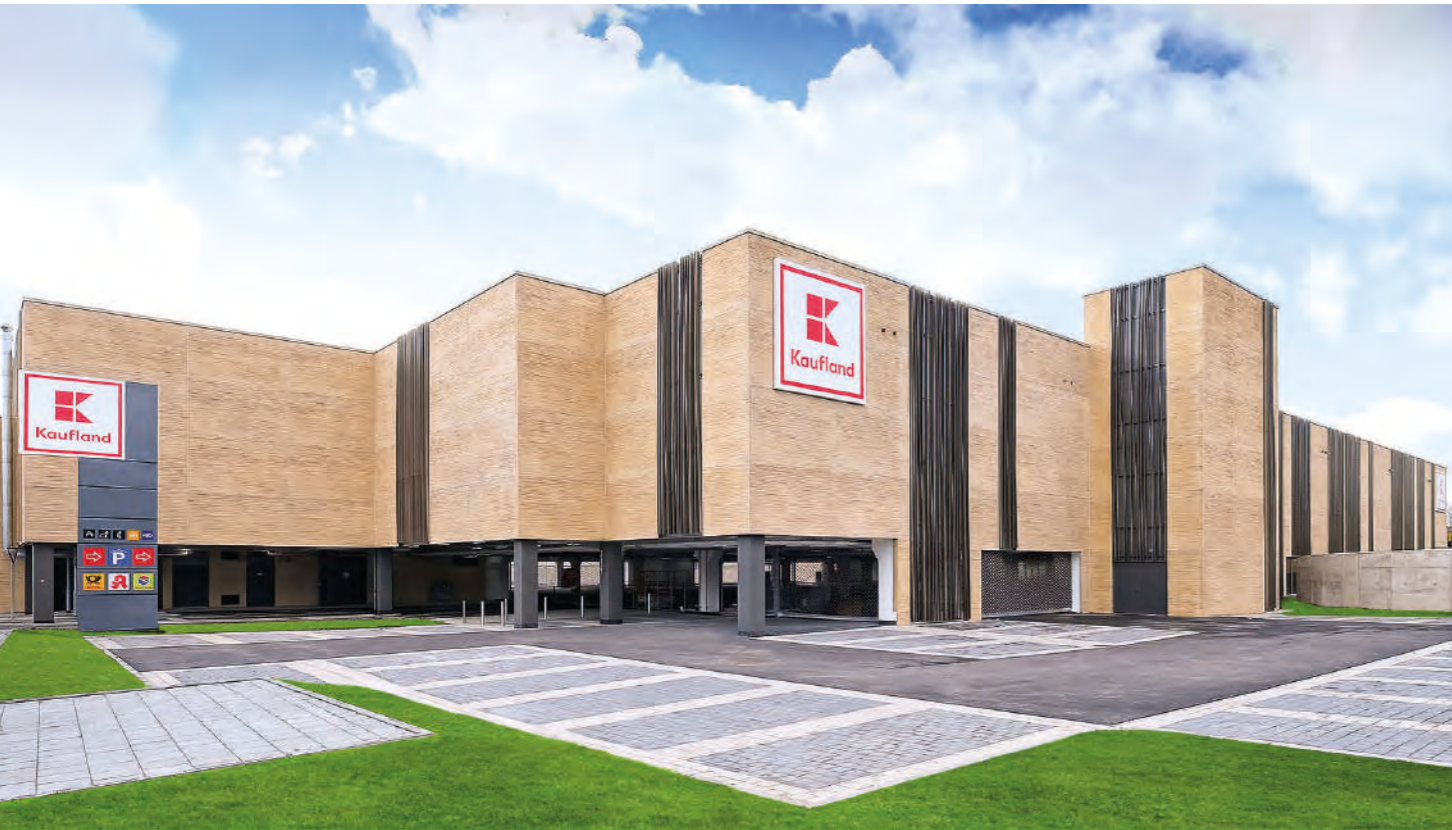
Eindrucksvolle Fassade durch eingefärbten Beton, Bambusstruktur mittels eingelegter Matrize und geschwungene Aluminium-Lamellen-Konstruktion
