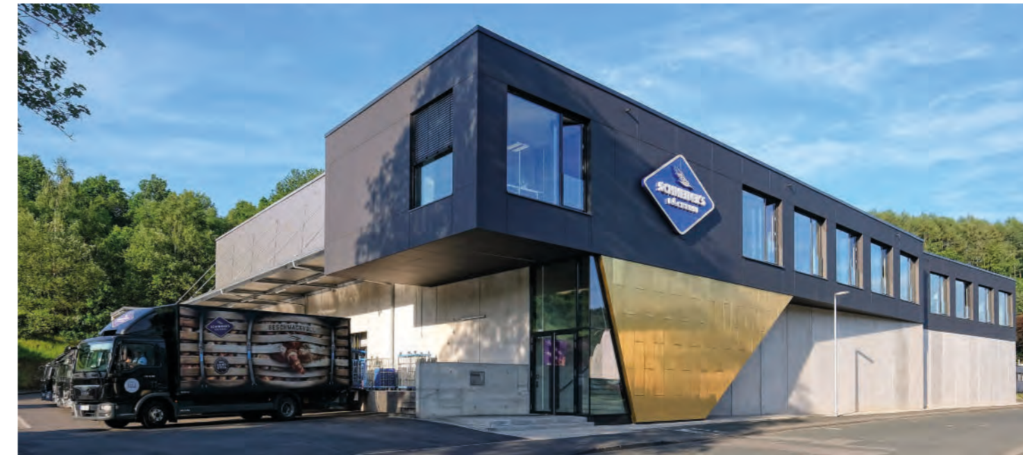
Blick auf die Erweiterung der Produktionshalle und des Hygienezentrums
