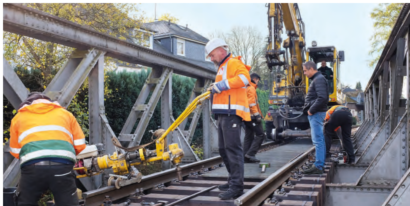
Endmontage der neuen Brückenschwellen in Teamarbeit
