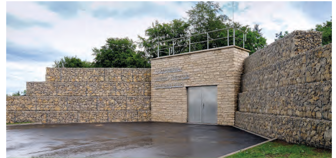
Eingangsportal des neuen Hochbehälters
