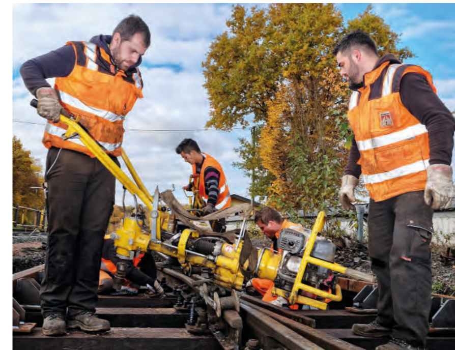
(v. l.) Alwin Weber, Fuad Ileri und Besart Ferizi beim Verschrauben der neuen Weichenschwellen
