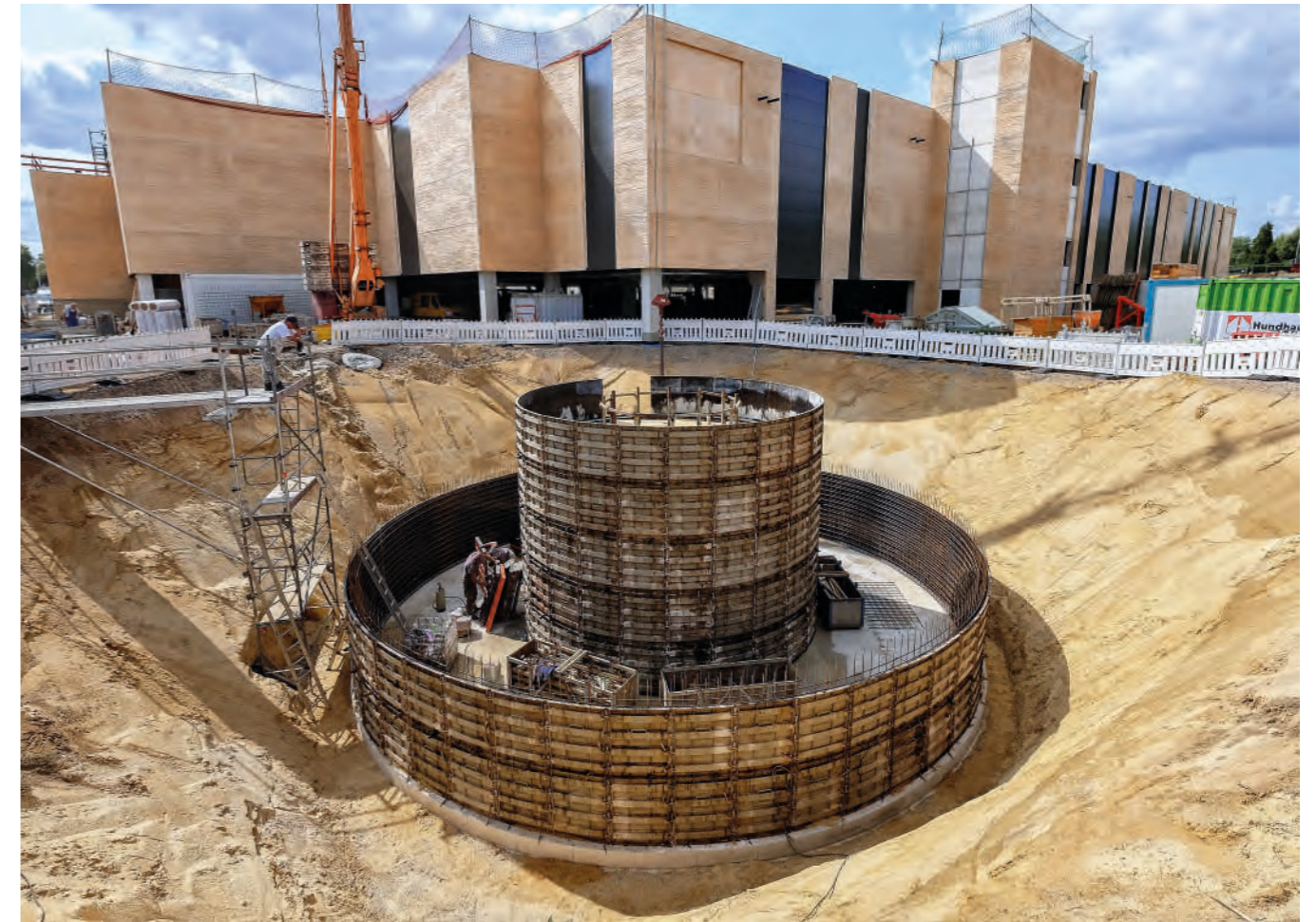
Aufstellung der Schalung für den 2-Kammer Monolith-Stahlbeton-Sprinklerbehälter
