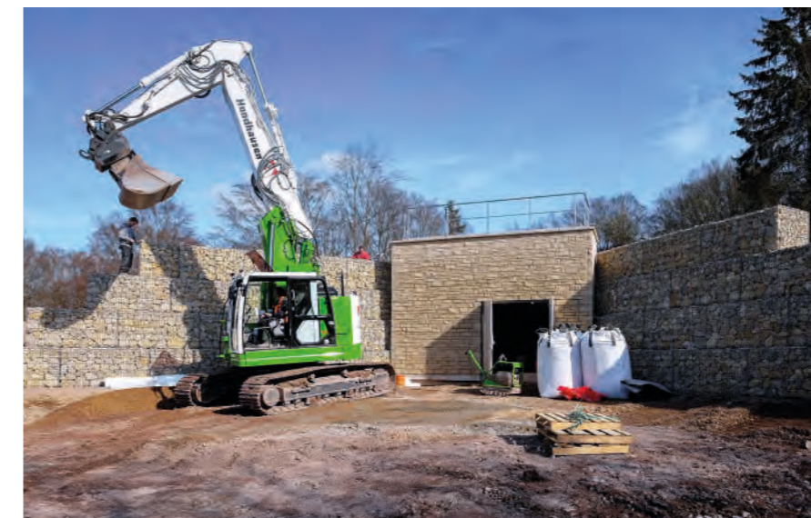
Punktgenaues Versetzen der Gabionen durch GPS-Steuerung
