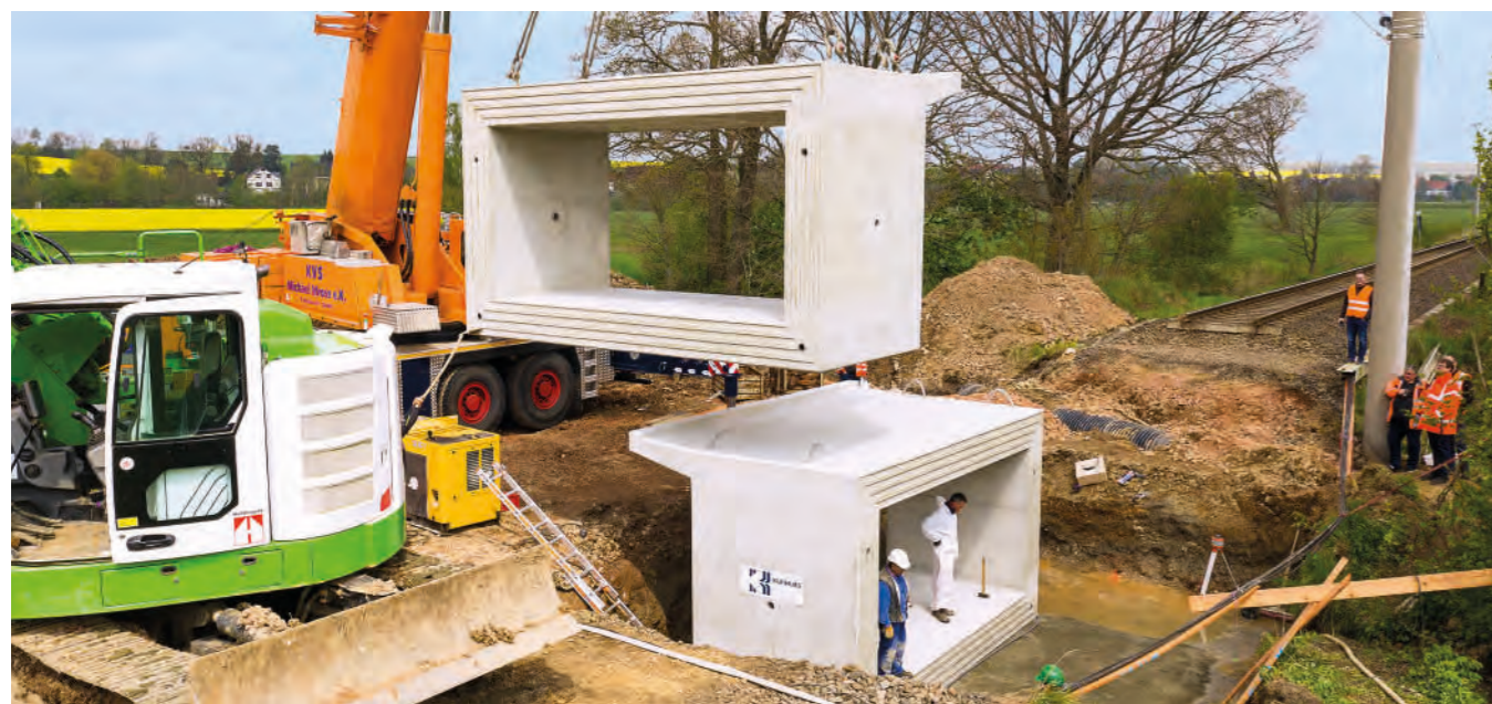
Verlegen der Vollrahmen auf Bodenaustausch und Ausgleichsschicht
