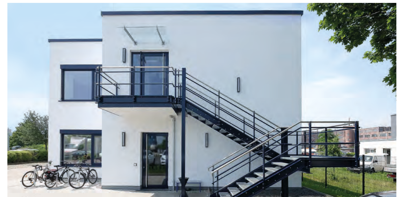
Der Sozialbereich im Obergeschoss ist ausschließlich über die separate Außentreppe erreichbar.
