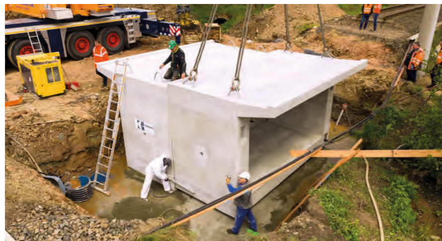
Einheben der Vollrahmen unter beengten Verhältnissen
