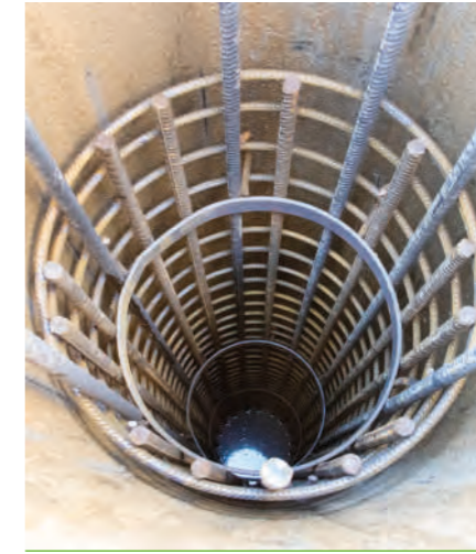
Bohrrohr mit eingelassenem Bewehrungskorb
