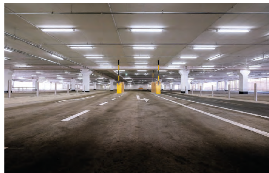
Blick in die 1.600 qm große Tiefgarage mit 160 Parkplätzen
