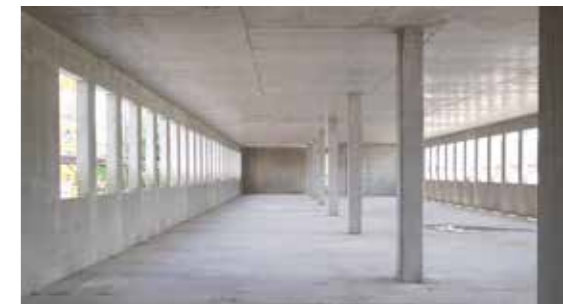
Rohbau-Fertigstellung eines „Taktbereiches“
