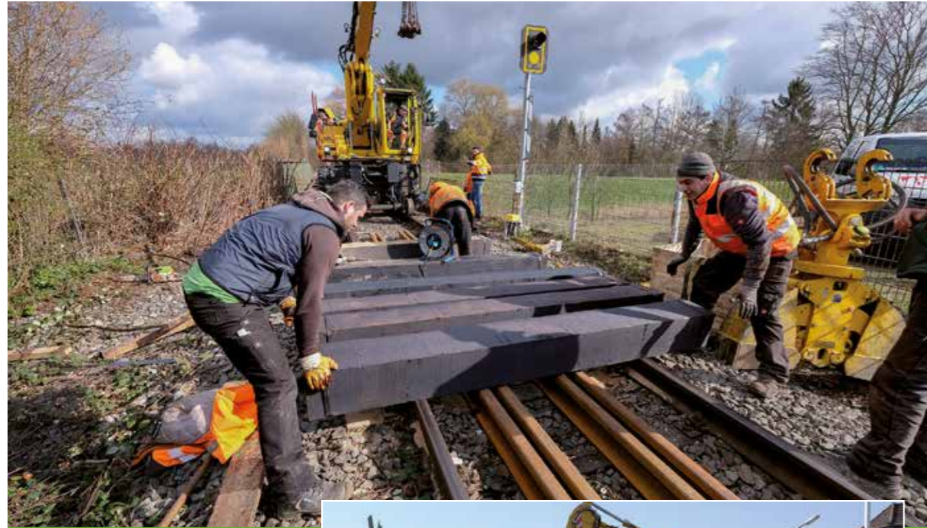
(v. l.) Besart Ferizi und Fatmir Tahiri beim Ausrichten der neuen Brückenschwellen
