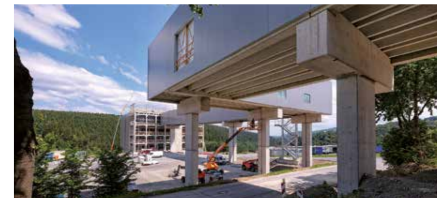
Blick auf die neue Verbindungsbrücke
