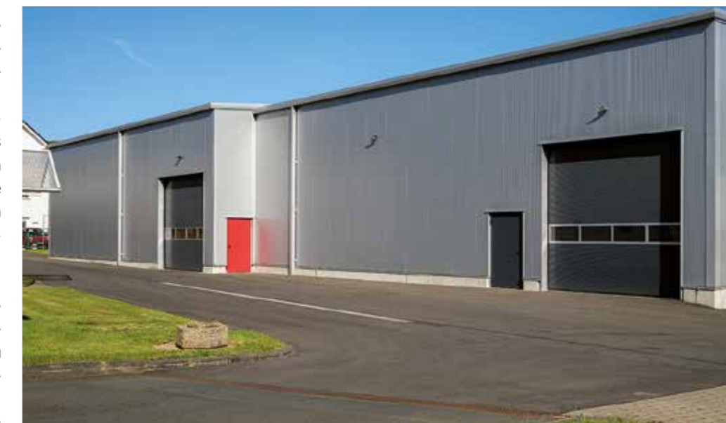
Außenansicht der neuen Lagerhalle
