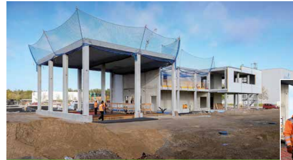
Rohbau des zukünftigen MAN TopUsed Centers
