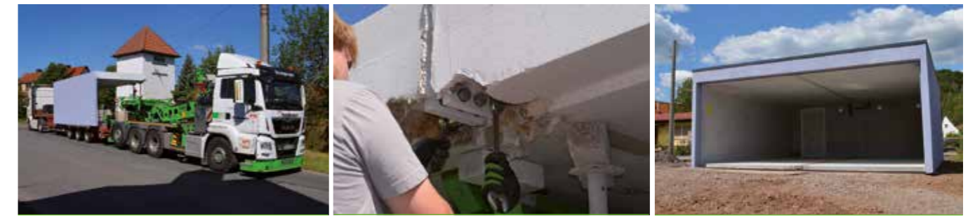
Transport der beiden Betonhälften der Großraumgarage
