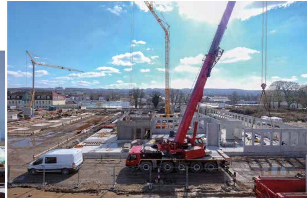
Fertigteilmontage im Erdgeschoss
