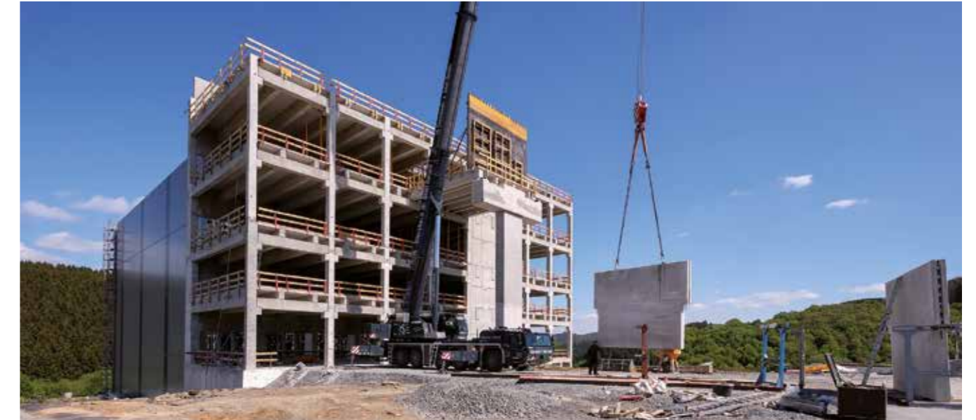
Montage des letzten Geschosses am Hochregallager
