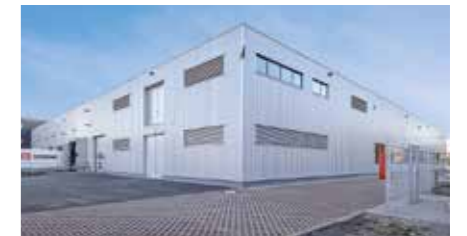
Nahtlos fügt sich der Neubau an die bestehende Halle an. Kaum erkennbar, dass nur eines der Anlieferungsstore neu ist.
