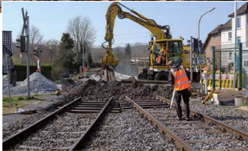
Kevin Helm beim Aufbau des Nivelliergerätes, im Hintergrund erfolgt der Schwellenausbau
