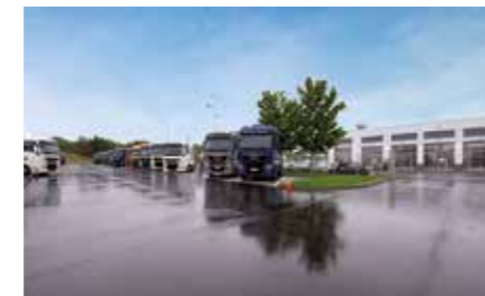
Neu angelegte Parkplatzfläche im östlichen Teil (im Hintergrund das Bestandsgebäude von MAN)
