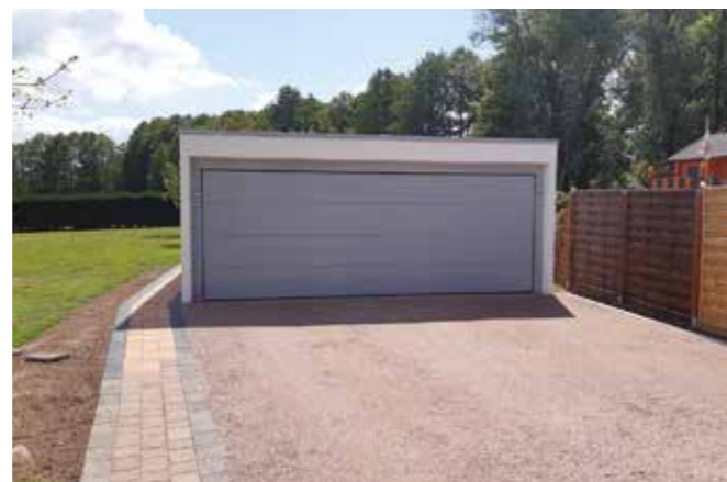
Schnellere Montage auf der Baustelle, Seite 15
