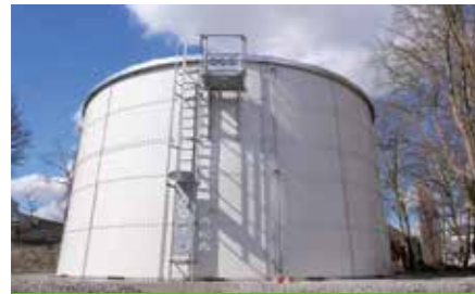
Sprinklertank im Außengelände
