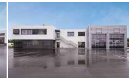
Westansicht mit Außentreppe und den Nebeneingängen
