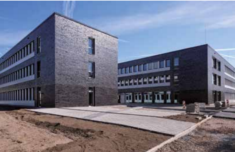
Blick von der Rheinischen Straße, Klinker-/Metallfassaden mit Holz-Aluminium-Fenstern
