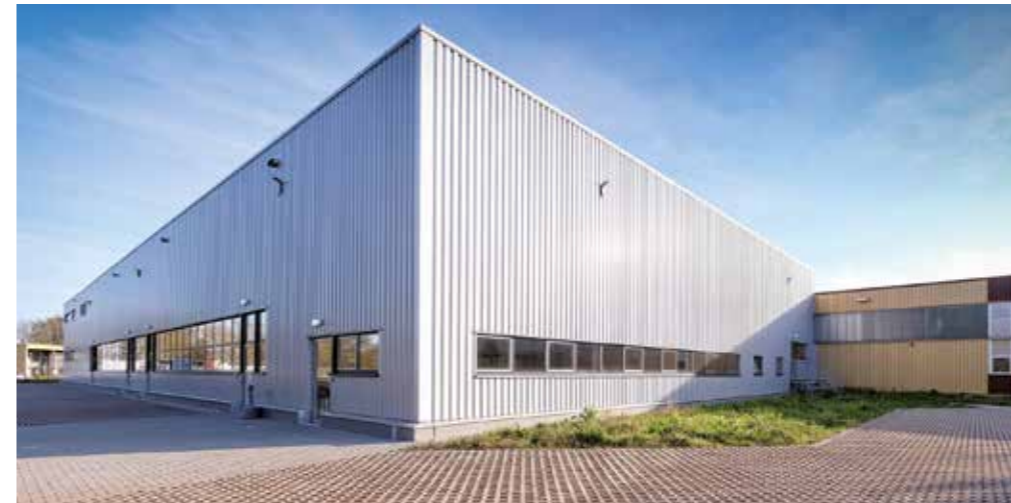
Rund 25 Jahre Altersunterschied zwischen Neubau und Bestandshalle (rechts). Die neue Feuerwehrezufahrt im Vordergrund teilen sich beide Hallen.
