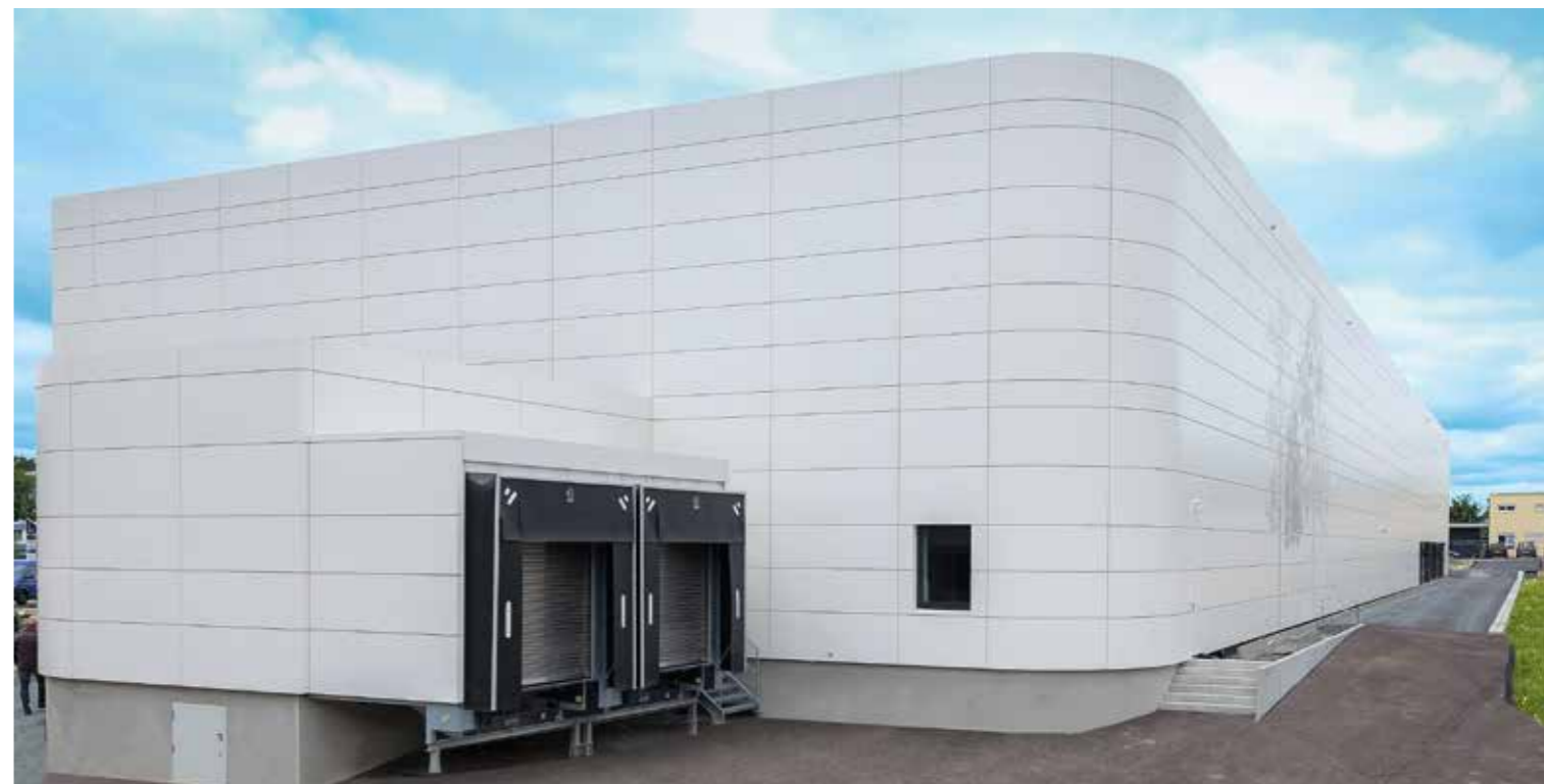
▼ Gerundete Außenwand des Lagergebäudes
