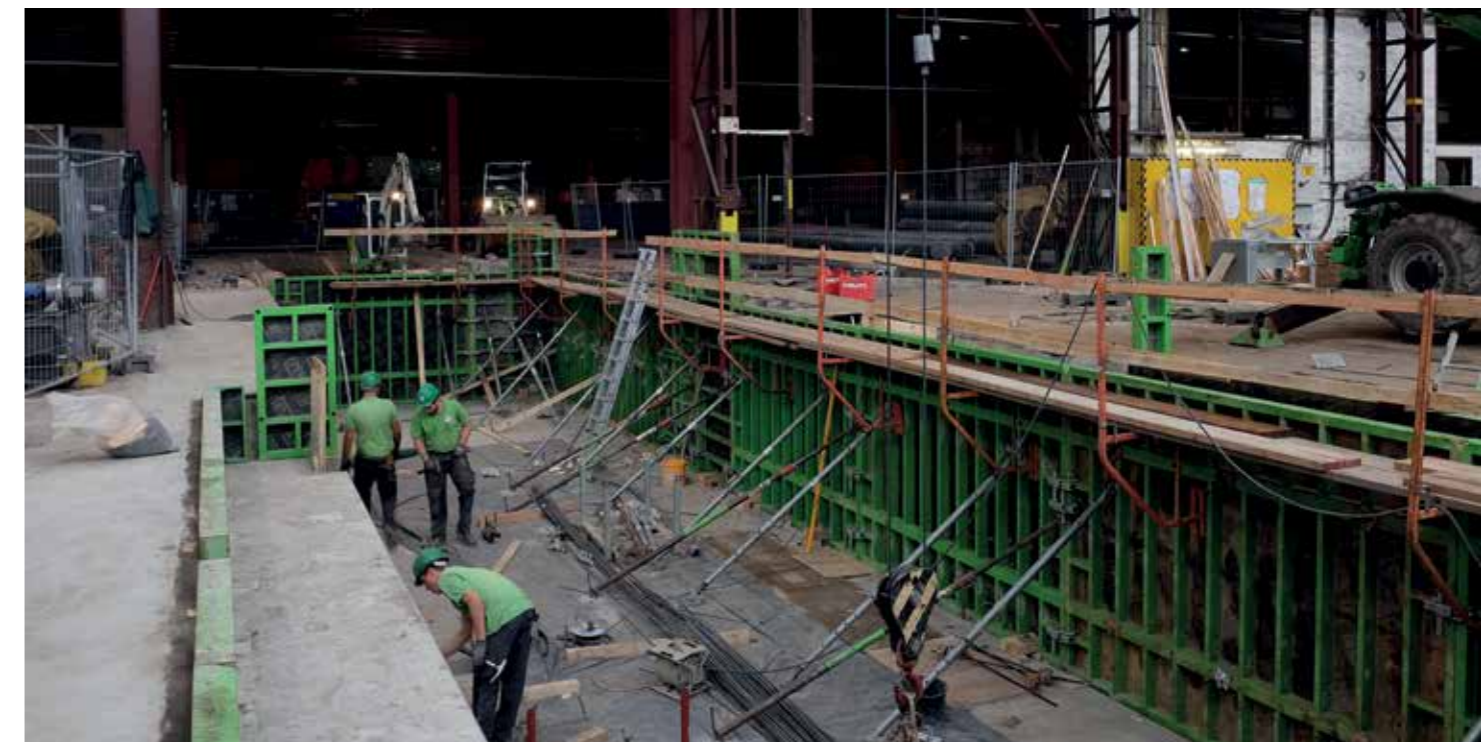
▼ Erstellung des Richtmaschinenfundamentes vor dem letzten Betonierabschnitt
