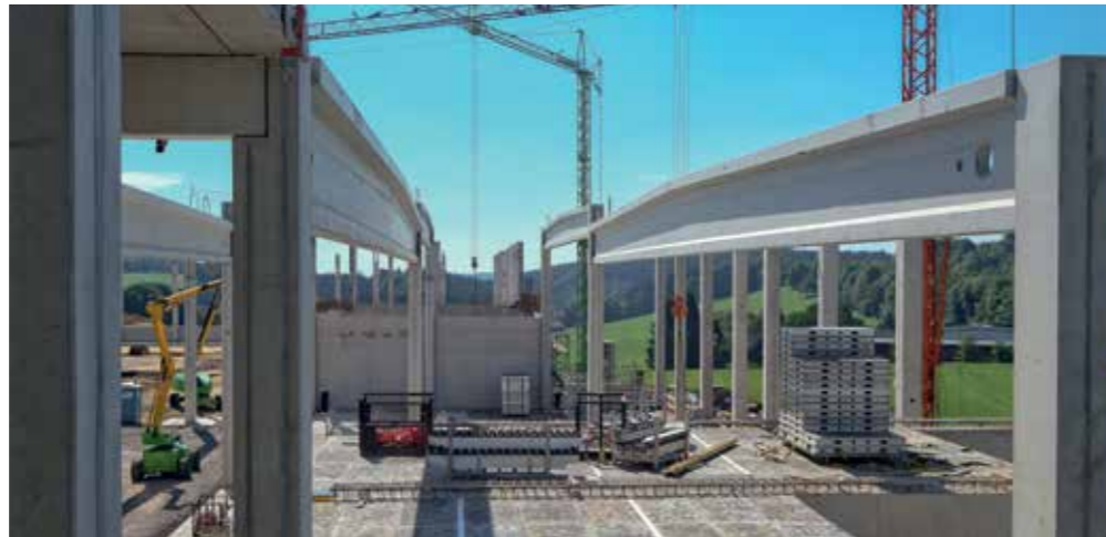
▲ Herstellung der Decke über dem Kellergeschoss
