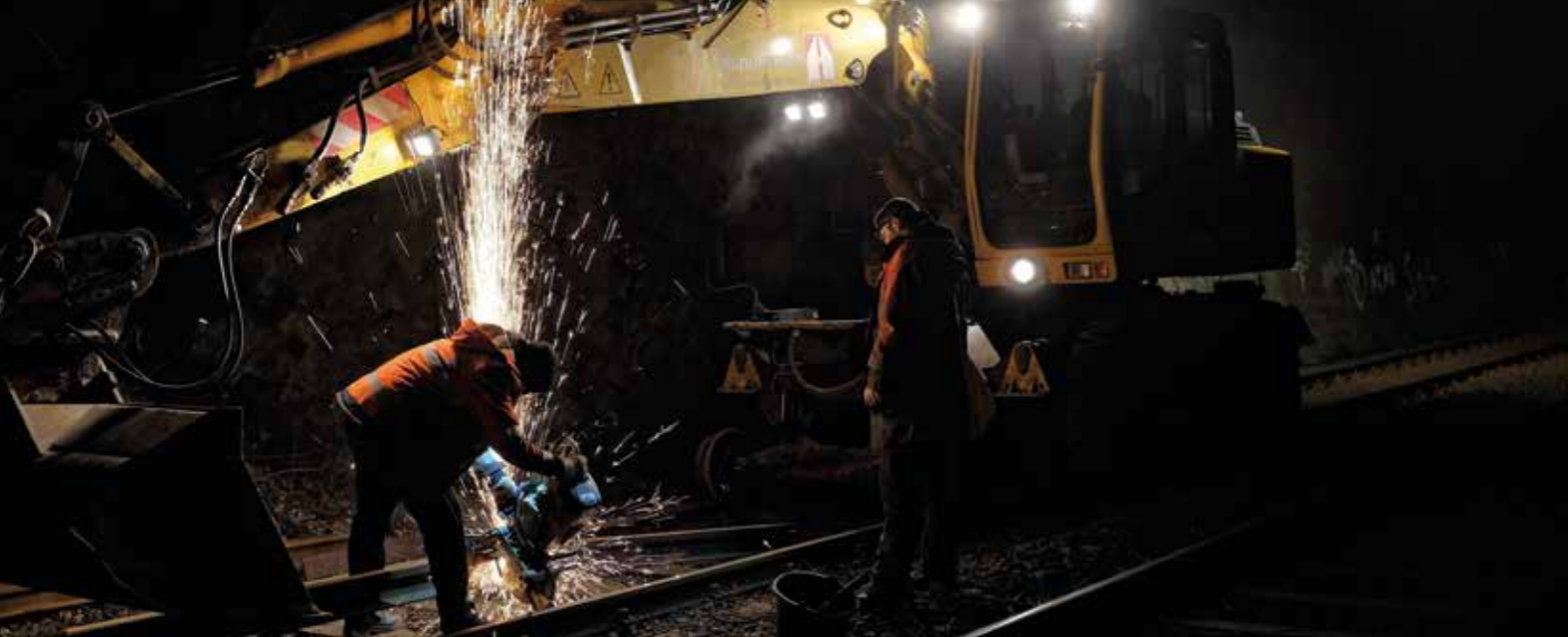
▲ Besart Ferizi und Alwin Weber beim Zertrennen der alten Schiene
