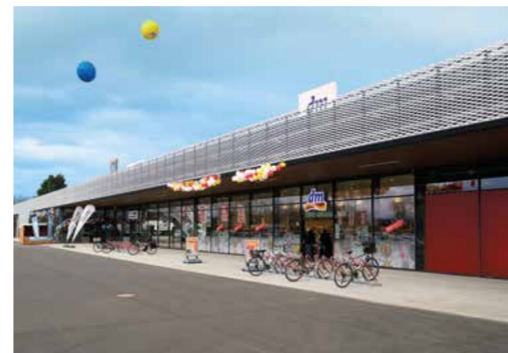
▲ Eine architektonische Raffinesse stellt die Streckmetallfassade dar.
