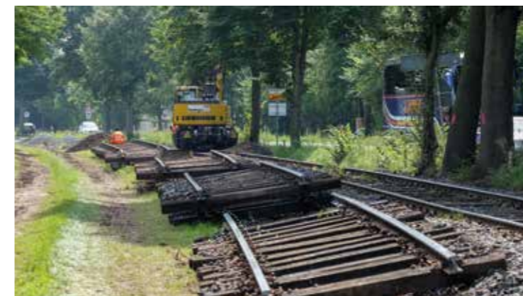
▼ Ausbau des alten Gleises
