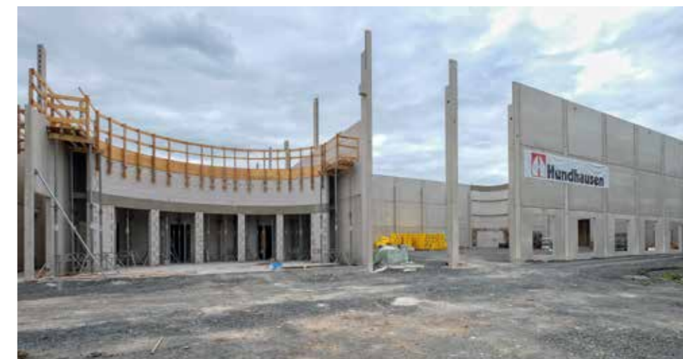
▲ Haupteingang an der Westseite im Bauprozess
