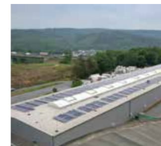
▲ Eine Photovoltaikanlage auf dem Dach der Fertigteilproduktion mit 496 Modulen zur Eigenstromversorgung mit einer Leistung von 140 kWp
