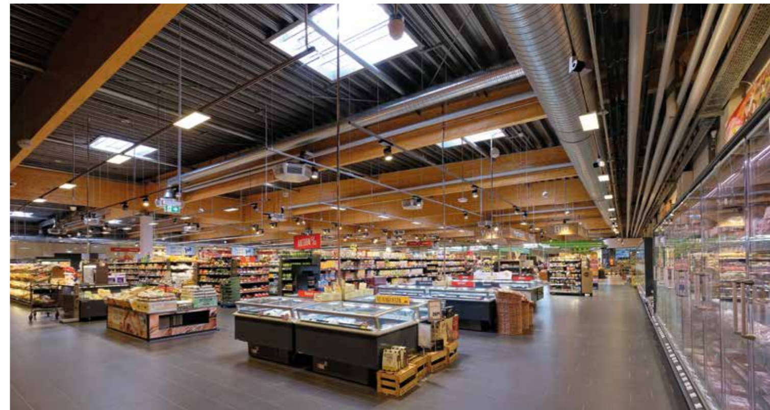
▲ Verkaufsraum des REWE-Marktes mit freiliegenden Holzbindern an der Decke
