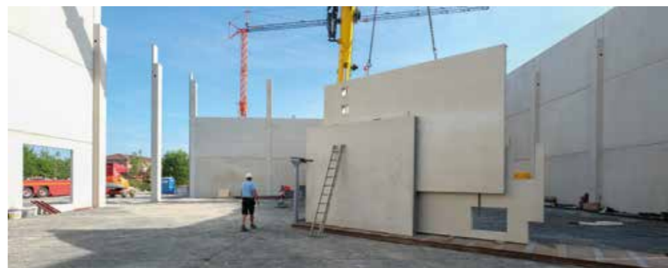
▼ Die Stahlbeton-Fertigteil-Wandscheiben für das Lager werden montiert.
