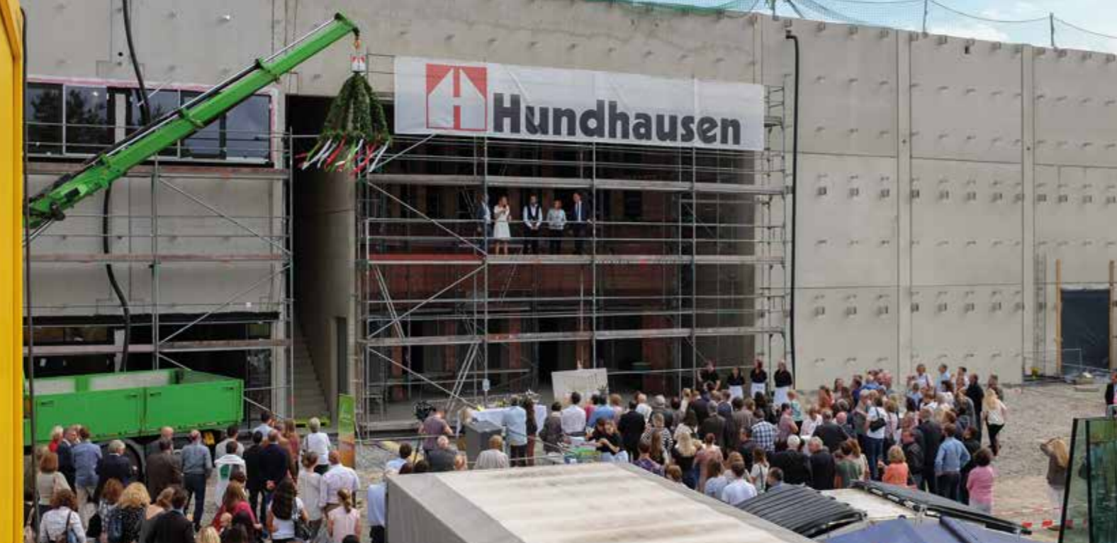
▲ Vor dem zukünftigen Haupteingang fand das Richtfest im vergangenen Jahr statt.
