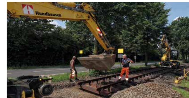
▼ Verlegen der neuen Gleisjoche
