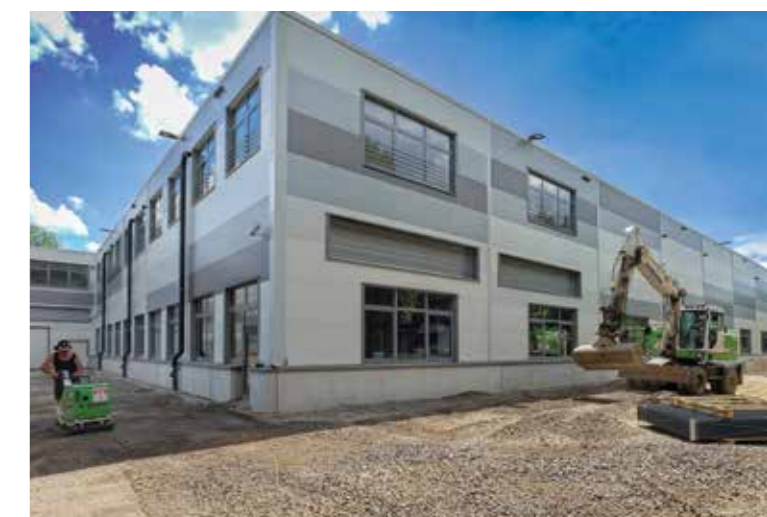
▼ Die Restarbeiten an der Feuerwehrumfahrt laufen.
