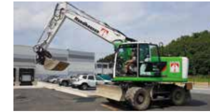
▼ Mobilbagger CAT M318F mit Topcon 3D Maschinensteuerung
