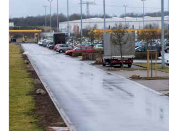
▲ Neue Fahrbahn aus Asphalt
