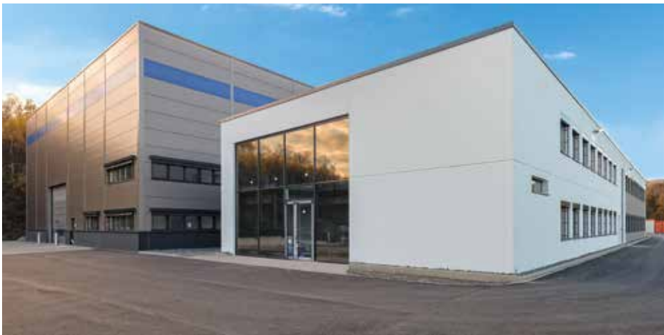
▲ Blick auf die fertiggestellte Zufahrt des Betriebsgeländes zur Halle und zum Bürogebäude der Klein AG
