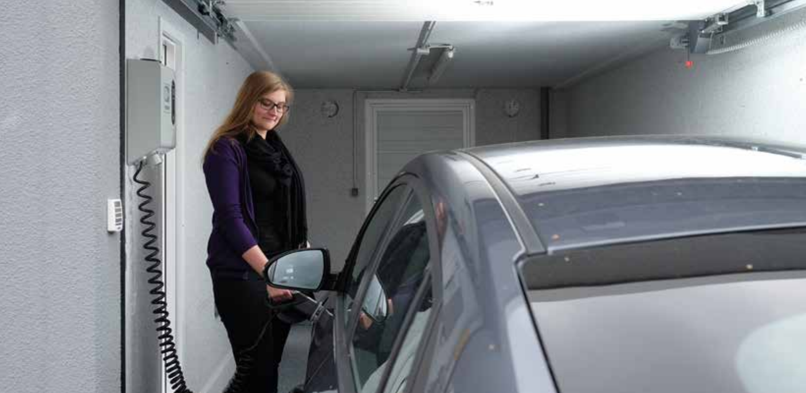
▲ Bequemes „Tanken“ in den eigenen vier Garagenwänden
