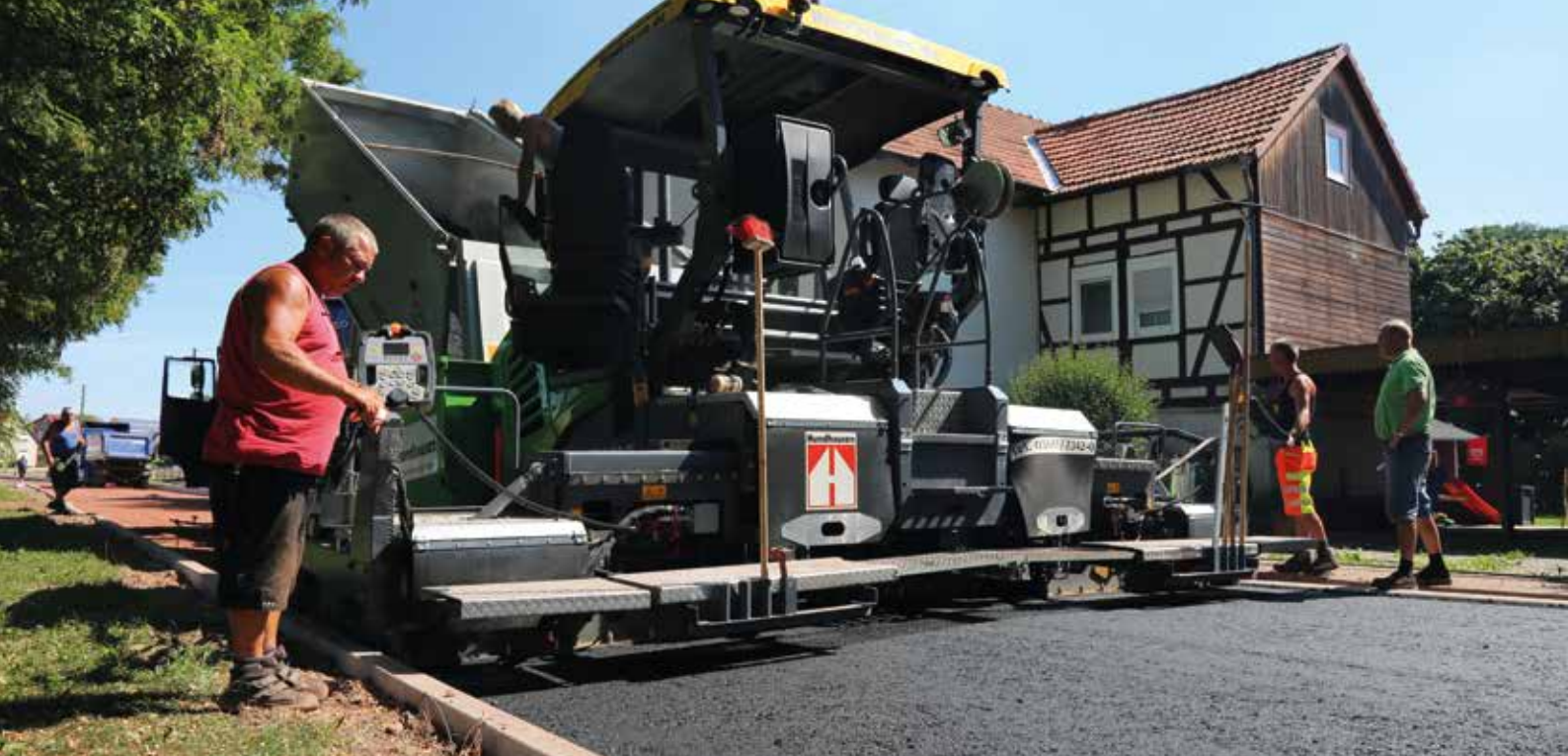
▲ (v. l.) Bodo Schröder, Stefan Hahn und Dirk Drescher beim Asphaltieren der Straßendecke
