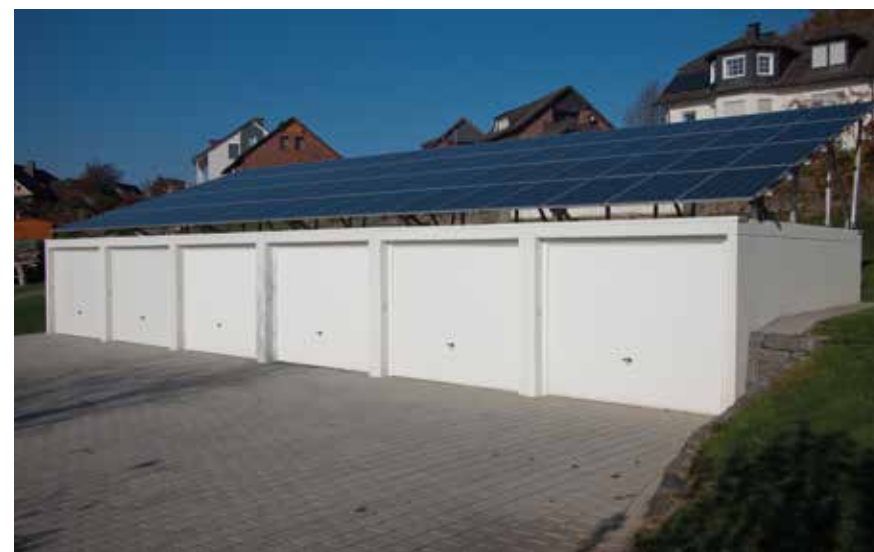
▼ Reihengaragen mit Photovoltaikanlage
