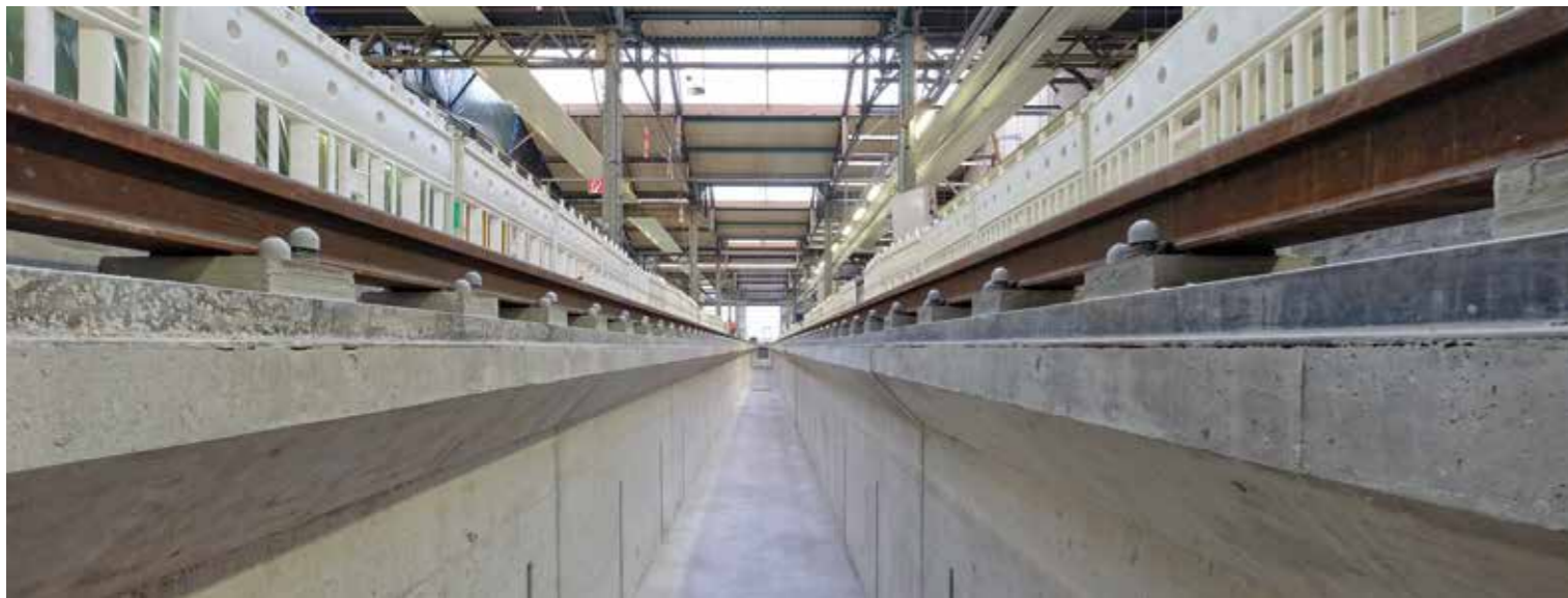
▲ Fertiggestellte Gleisgrubenverlängerung
