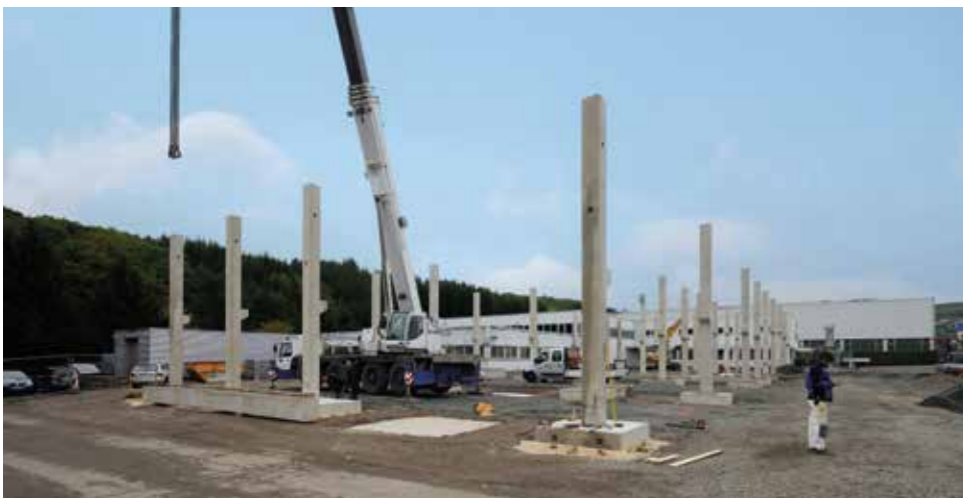
▼ Montage der Fertigteilkonstruktion für die neue Halle
