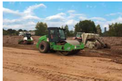
▼ Bodenstabilisierung für das Erdplanum mittels Kalk-Zement-Gemisch
