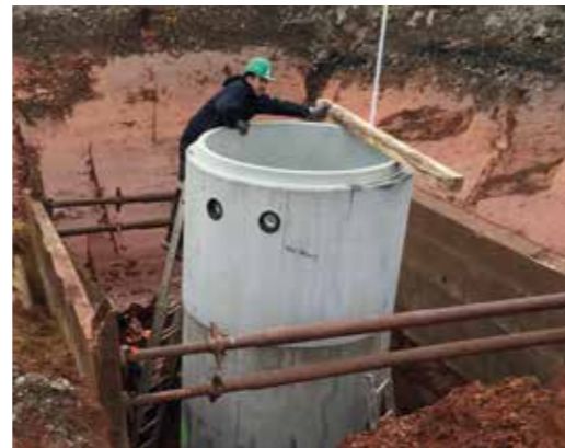
▲ (v. l.) Michel Meder und Thomas Rödiger fertigen den Pumpenschacht für das Abwassersystem.
