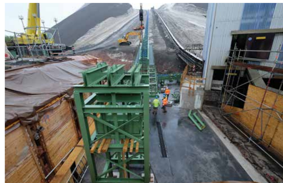
▼ Montage der neuen Förderanlage
