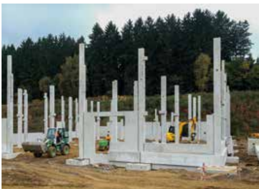
▼ Erster Montageabschnitt der Fertigteile (Stützen mit angeformten Fundamenten und Sockelelementen)
