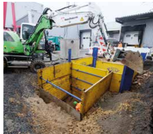
▲ Baugrube für den neuen Fettabscheider
