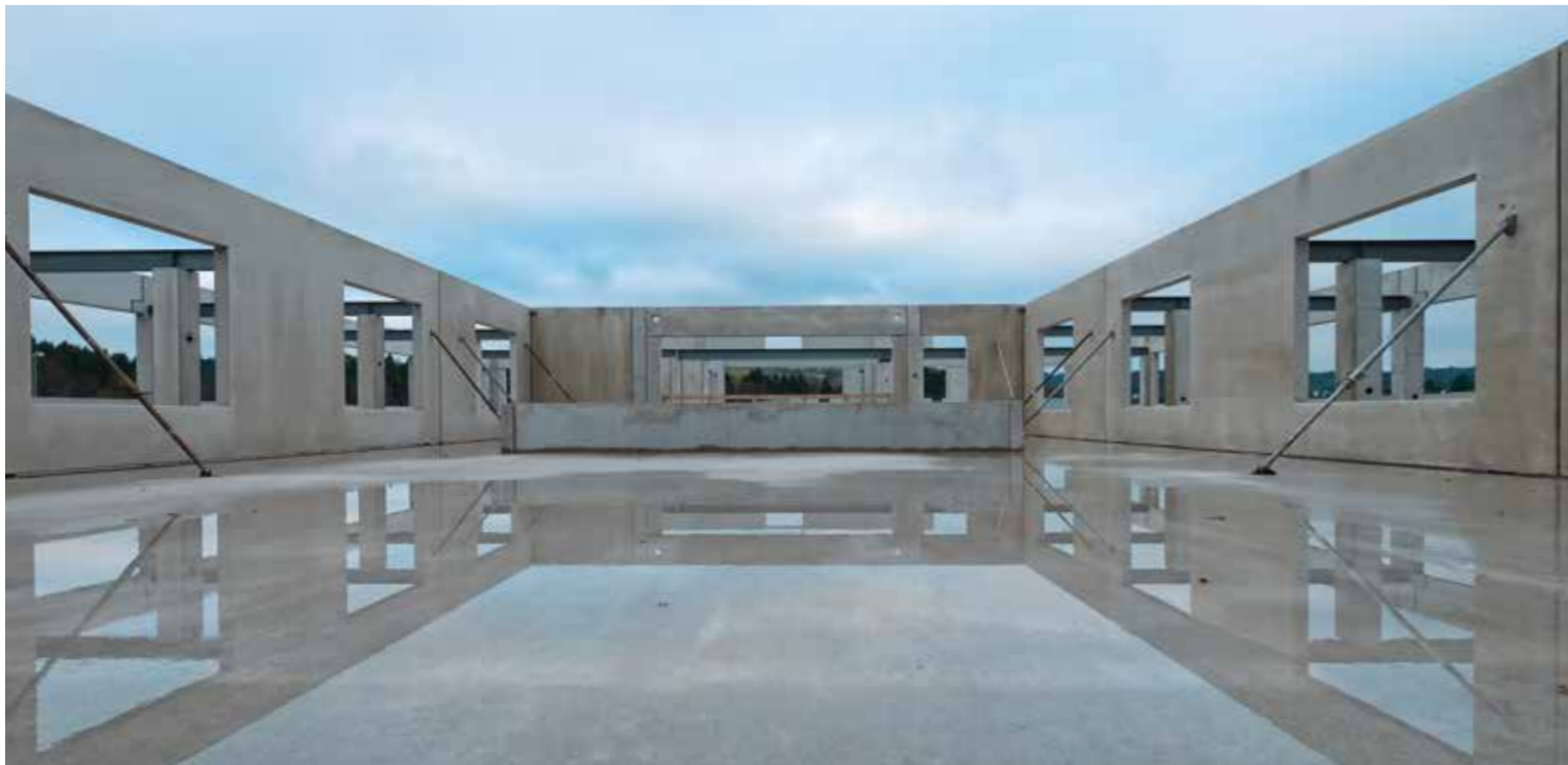
▲ Blick auf die spätere „offene Dachterrasse“ mit Atrium im Erdgeschoss
