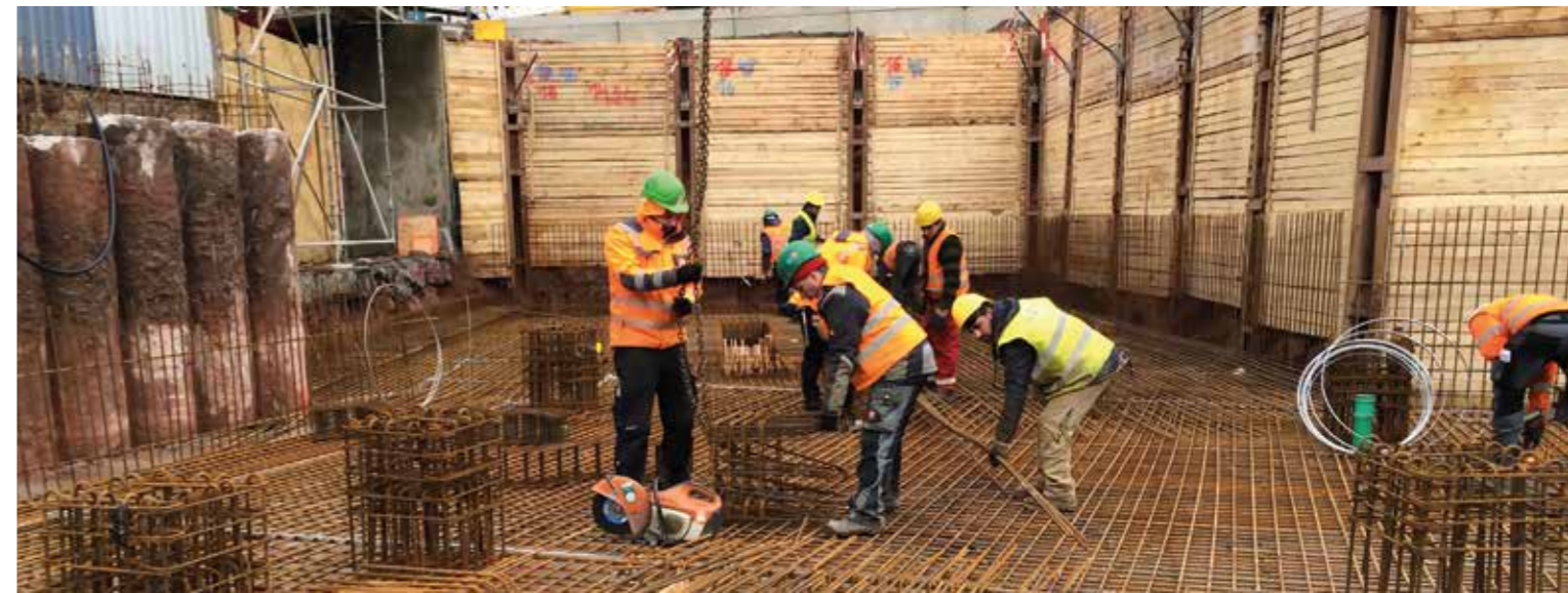
▲ Eisenbiegearbeiten der Bodenplatte mit seitlichem Baugrubenverbau, links sind die Bohrpfähle gut erkennbar.
