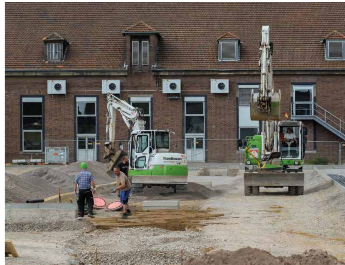
▲ Der neue Mitarbeiterparkplatz wird erstellt.
