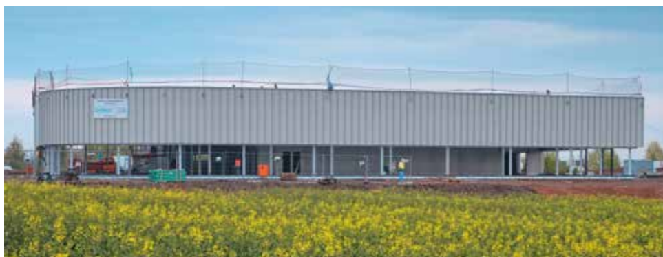
▼ Fertiggestellter Rohbau mit Blick auf die späteren Ausstellungsfensterflächen
