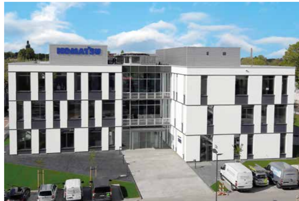
▼ Alu-Pfosten-Riegelfassade am Haupteingang und abgesetztes Wärmedämmverbundsystem
