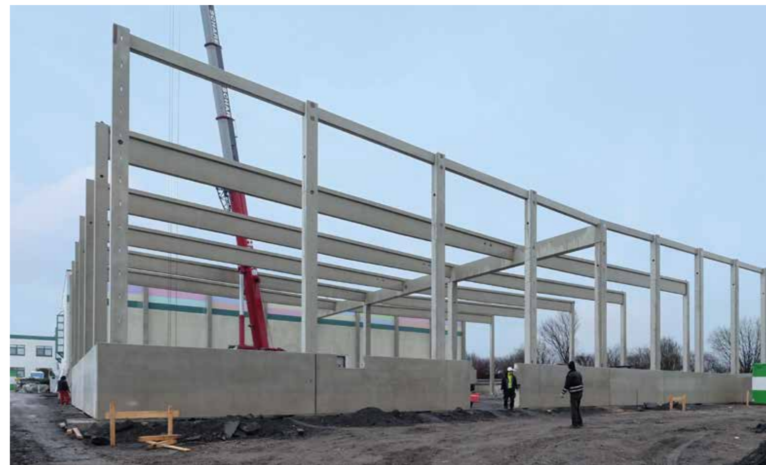
▼ Fertigteilkonstruktion der Produktions- und Lagerhalle
