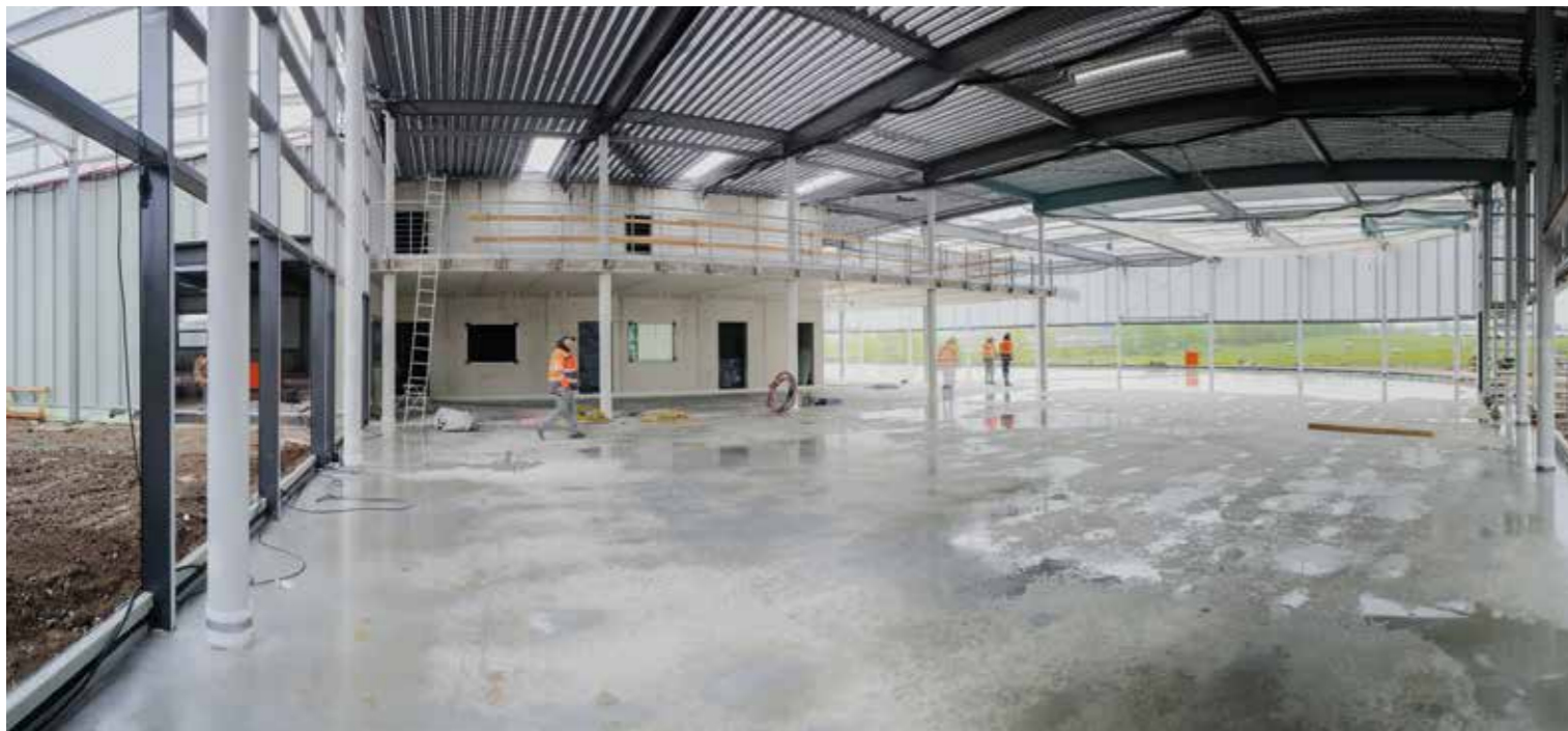
▲ Fertigstellung des Industriebodens in der Ausstellungshalle mit Blick auf die Galerie im Hintergrund
