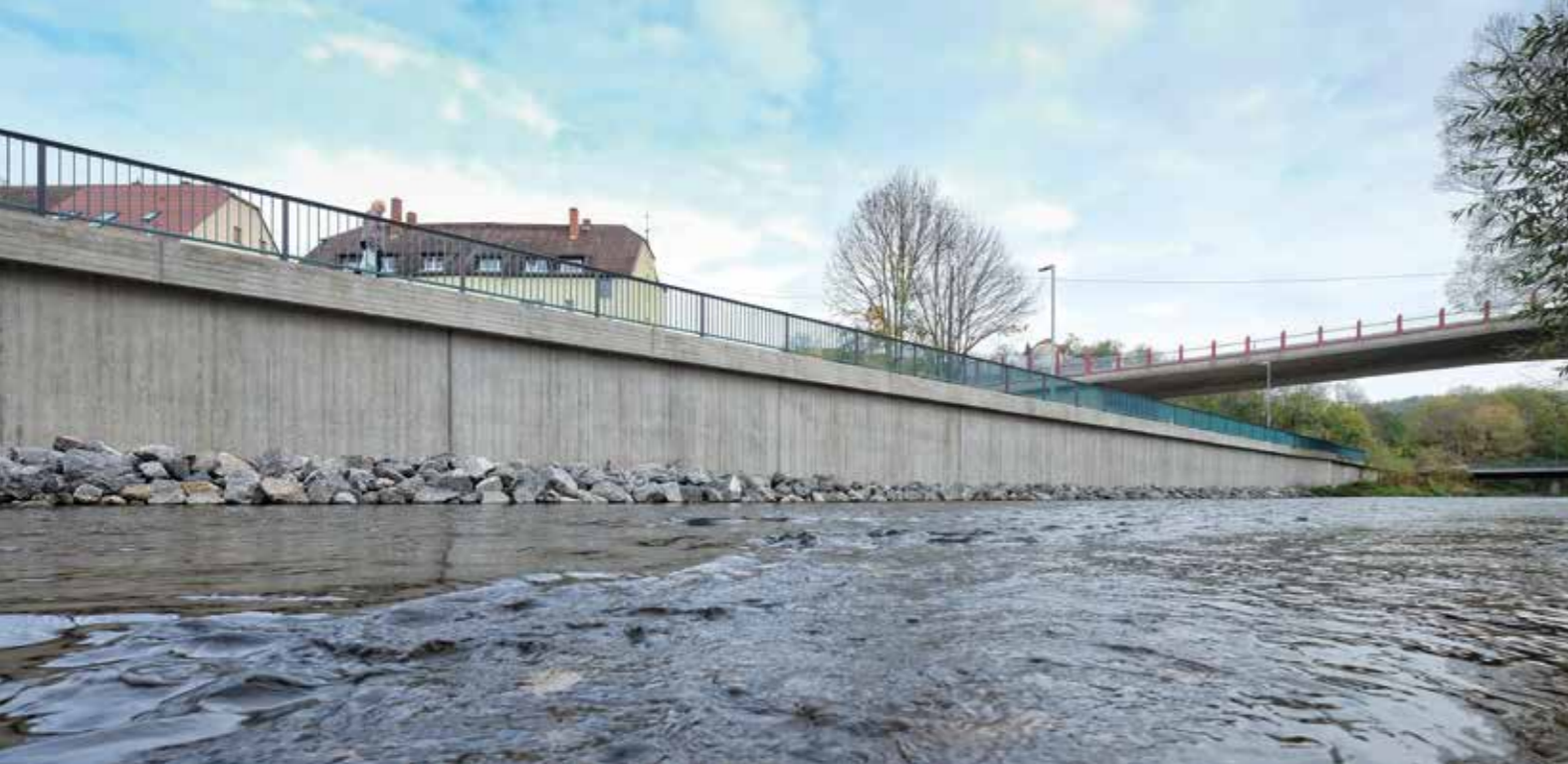
▲ Neu errichtete Stützwand mit Kappe und Geländer
