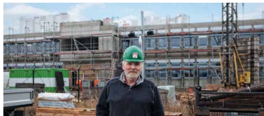
▼ Polier Karsten Klein und sein Team sorgten für den reibungslosen Ablauf der Rohbauarbeiten
