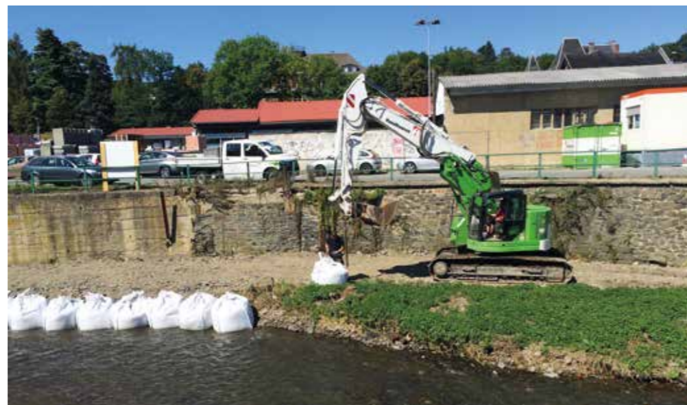
▲ Ferry Bergmann beim Setzen der BigBags zur Wasserhaltung und Bau der Baustraße. Im Hintergrund ist noch die alte Stützwand (vor der Sanierung) zu erkennen.
