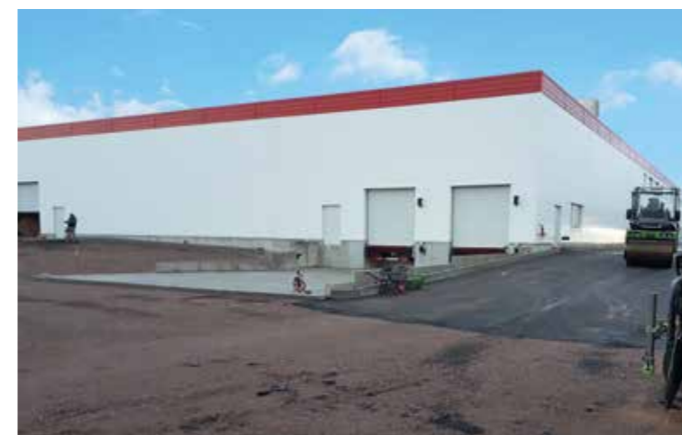
▲ Blick auf die neue Produktionshalle, zur Zeit laufen die Außenanlagen und der Innenausbau.
