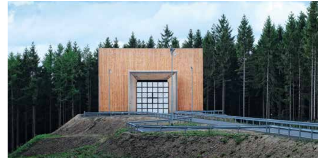
▲ Blick auf den Geschossfang mit Holzverkleidung und die 6 m x 6 m Treffbildscheibe
