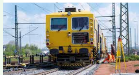
◀ Stopfmaschine Unimat beim Stopfen der Messgleis-Strecke
