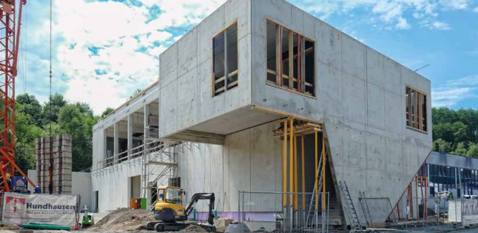
▲ Rohbau-Ansicht vom Treppenhaus mit angegliedertem Hygienezentrum bzw. Produktionshalle
