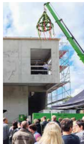
▲ Das Richtfest wurde am 10. September gefeiert.
