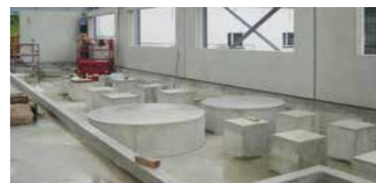
▲ Behälterfundamente vor der Verkleidung mit Säureschutzfliesen
