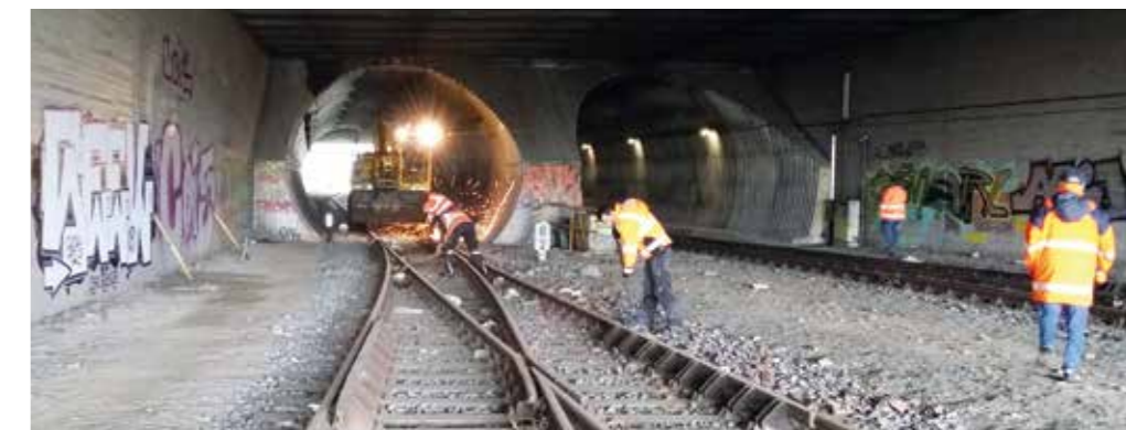
▲ Rückbau einer Weiche in der Eisenbahn-Unterführung, Kreuzung Landstraße/Ratsweg-Kreisel
