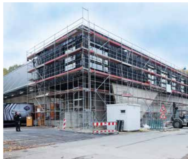
▲ Die Fassaden-Arbeiten sind zur Zeit in vollem Gange.
