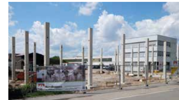
▲ Die Hundhausen-Stahlbeton-Fertigteile ermöglichten eine rasche Errichtung des Rohbaus.
