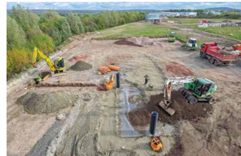
▲ Die Tiefbauarbeiten für die Verladezone sind in vollem Gange.
