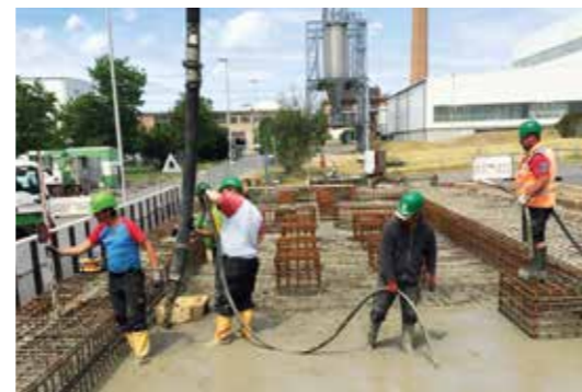
▲ Frähsommer 2017 Betonage der 0,7 m – 1,30 m starken, tragenden Bodenplatte
