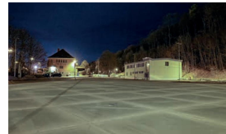
▼ Der Busbereitstellungsplatz ist fertiggestellt.
