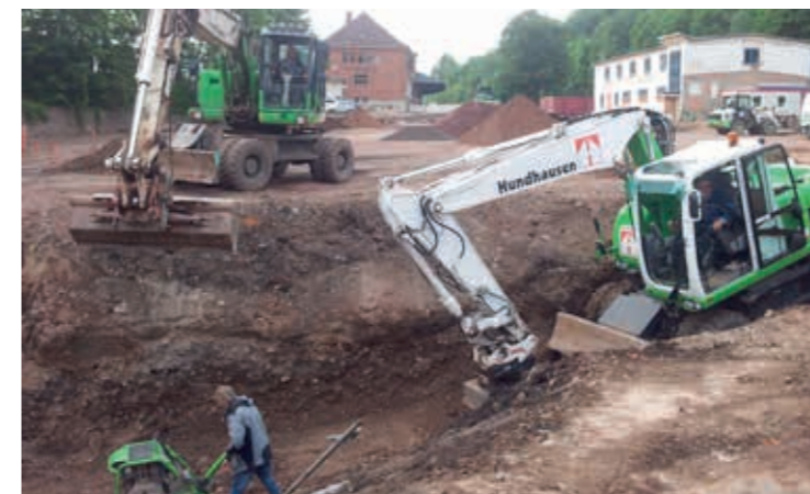
▼ Die Tiefbauarbeiten sind in vollem Gang.
