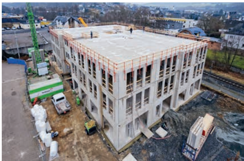
◀ Ansicht der Fertigteilkonstruktion während der Rohbauphase
