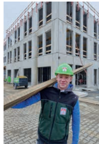
▲ Sebastian Klappert auf der Baustelle
