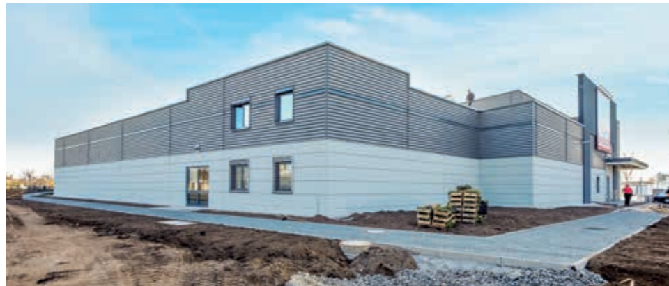
▼ Rohbauphase mit Montage der Fertigteile und Erstellung des Parkplatzes
