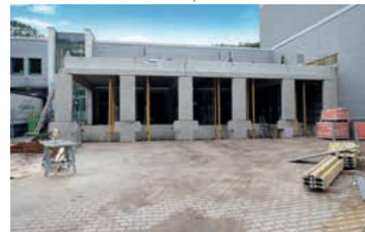
▼ Gebäude mit neuen Laderampen
