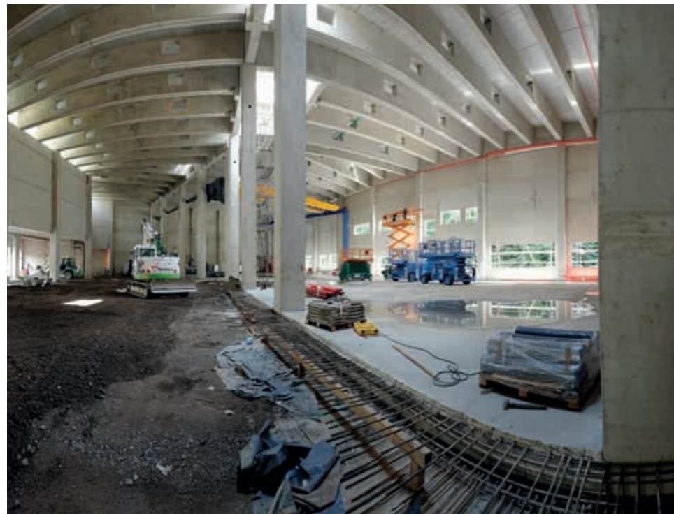
▼ Hallen-Innenansicht mit Blick auf die Fertigteilkonstruktion
