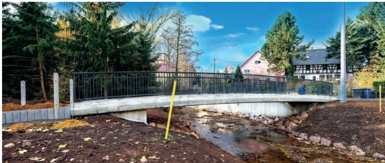
▼ Die fertiggestellte Fußgängerbrücke kurz vor der Abnahme
