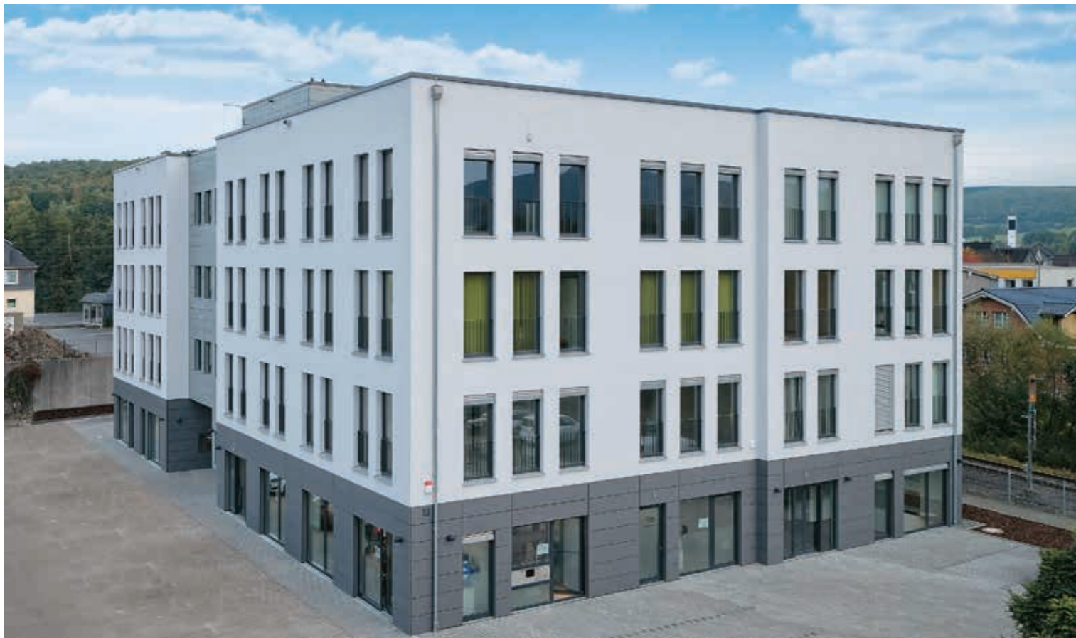
▲ Das Medizinische Zentrum ist fertiggestellt und wurde schlüsselfertig übergeben.
