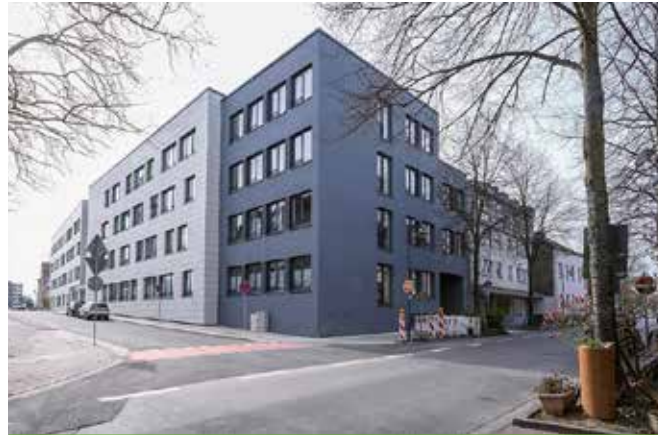
Neubau eines Jobcenters in Alsdorf, Seite 4-5
