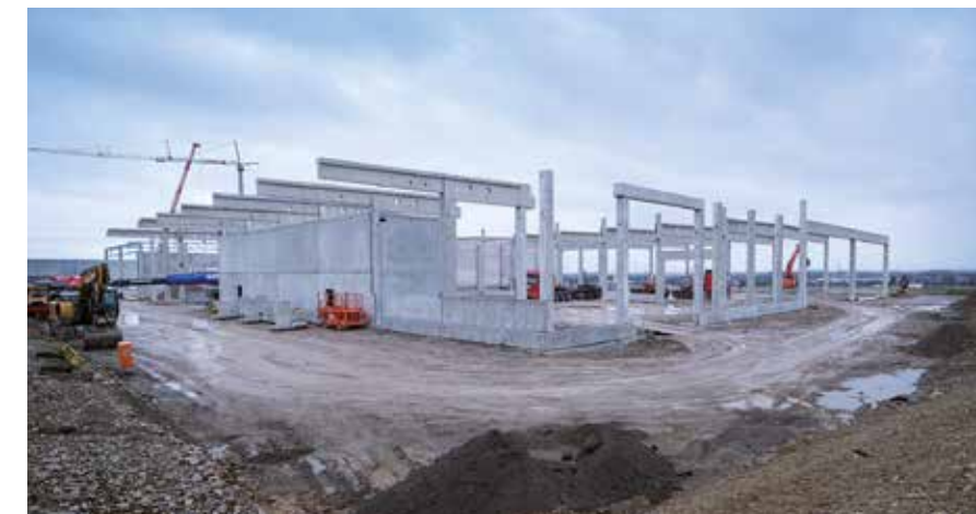
Die Montage der Dachbinder ist kurz vor der Fertigstellung.
