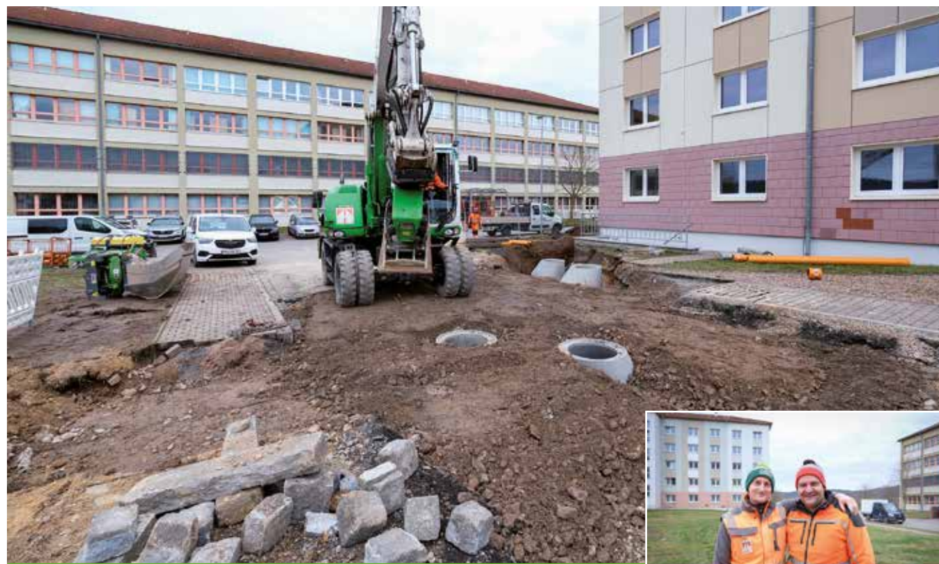
Verfüllung des Kanalgrabens mit Mobilbagger und Anbau-Verdichterplatte
