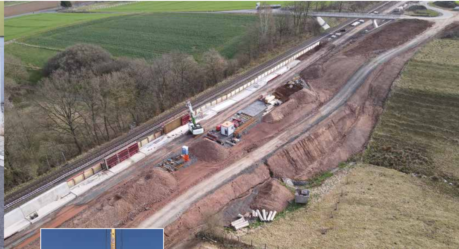
Luftbildaufnahme der Winkelstützwand Nord, direkt am Gleis
