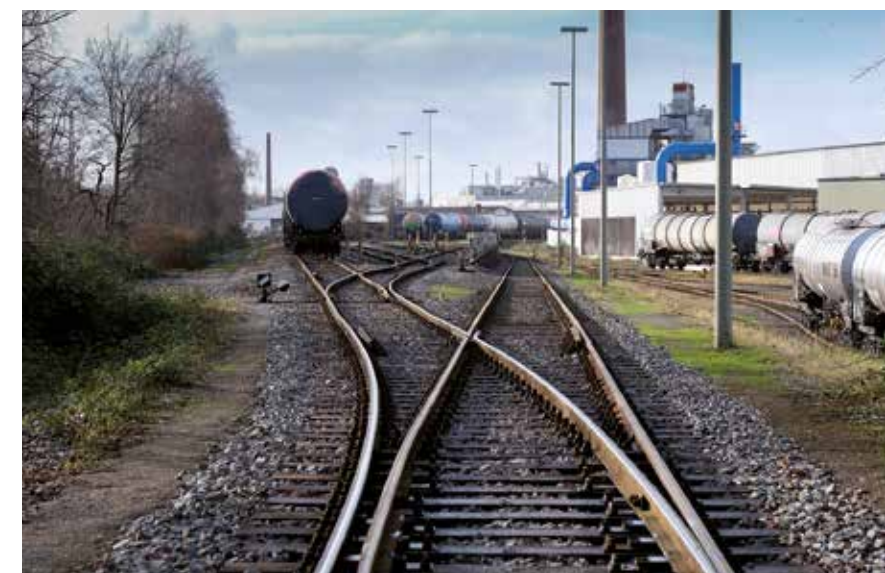
Die Weiche wurde im Zuge der Instandsetzung neu besohlt und gestopft.
