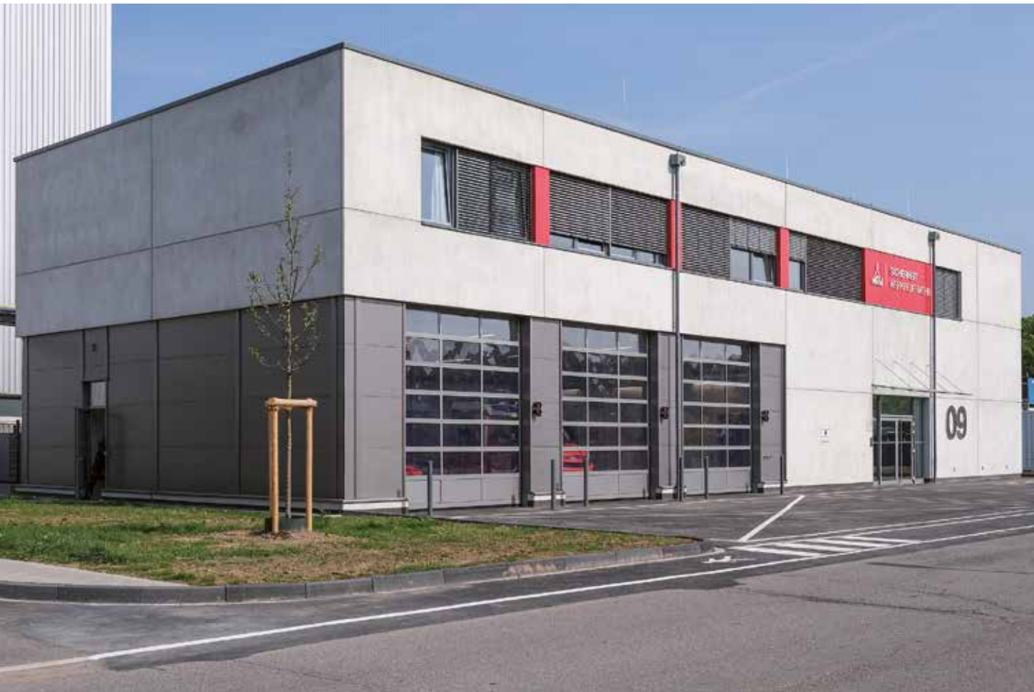
Außenansicht der neuen Feuerwache
