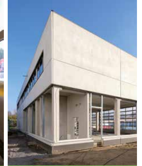
Gelungener Rohbau mit Stahlbeton-Fertigteilen aus unserem Werk in Siegen-Eisern
