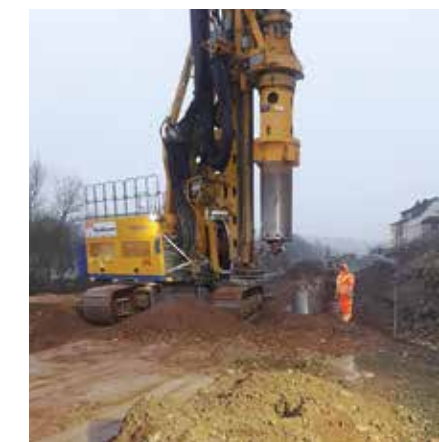
Die Bohrpfahlarbeiten an der Stützwand Süd schreiten voran.
