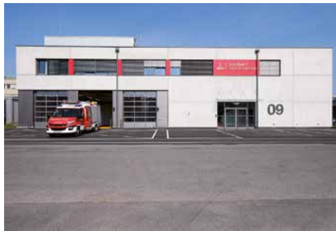
Neubau einer Feuerwache für die DEUTZ AG, Seite 16-17
