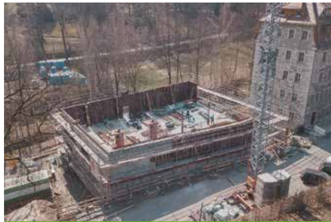
Rohbau eines Büro- und Produktionsgebäudes für imk in Kleinolbersdorf, Seite 10
