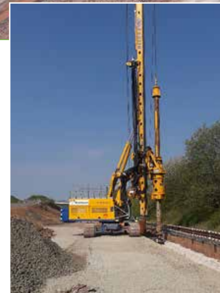
Das Bohrpfahlgerät an der Pfahlwand Nord am Gleis im Einsatz
