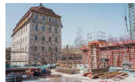
Das erste Obergeschoss des neuen Büro- und Produktionsgebäudes ist fertiggestellt.
