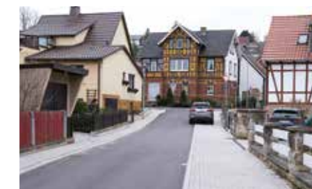
Straßenanschluss an die B 62
