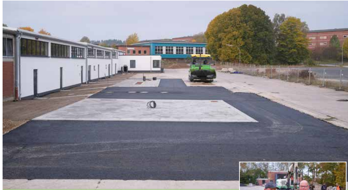
Die Anpassungsflächen für den Tank- und Waschplatz mit Abscheider sind asphaltiert.
