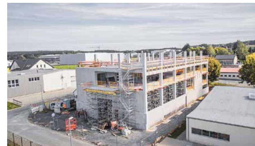
Nord-West-Ansicht des neuen Betriebsgebäudes. Der Rohbau ist bis zur Büroebene fertiggestellt.
