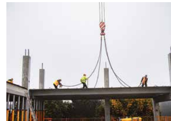
Das Hundhausen-Team vom Standort Hilmersdorf verlegt die TT-Decke.
