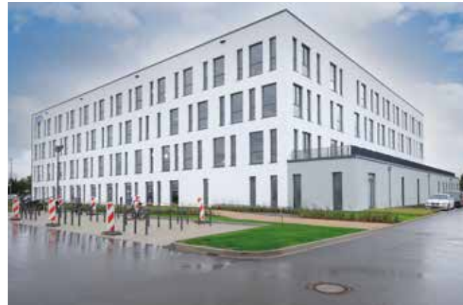
Neubau eines Betriebs- und Verwaltungsgebäudes für ENNI in Moers, Seite 4-5
