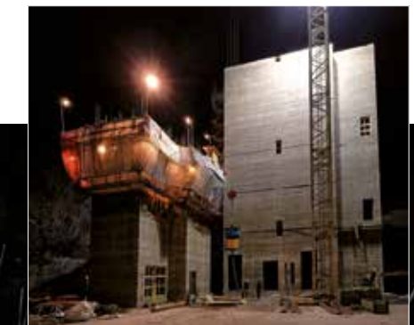
Gleitbau des Schachtwerkes T1 im Nachtbetrieb. Der Turm 5 war zu diesem Zeitpunkt bereits fertiggestellt.
