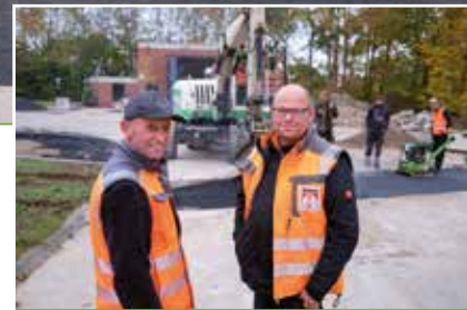
(v. l.) Stefan Hahn und Dirk Drescher sind zufrieden mit dem Bauablauf.
