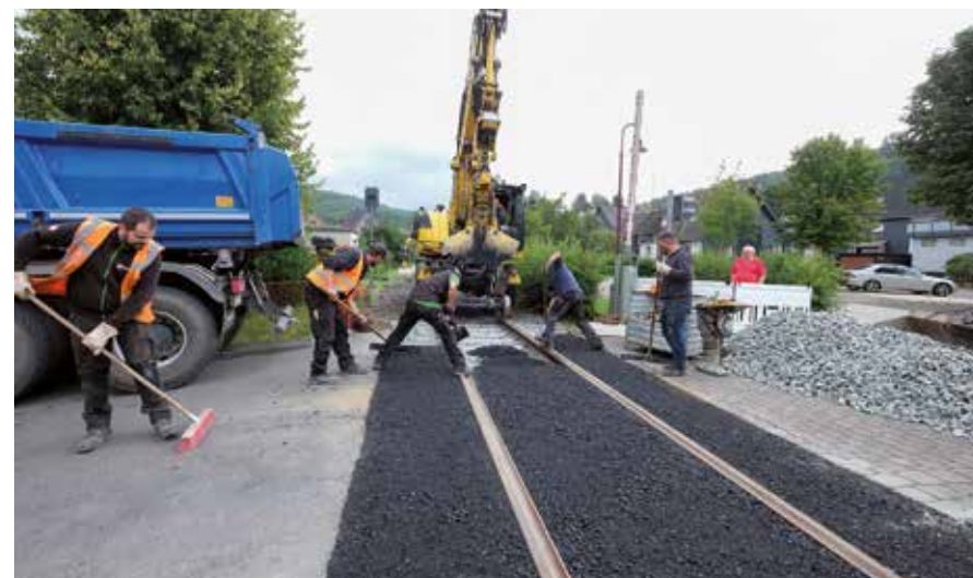
Im Bereich des Bahnübergangs wird die Deckschicht asphaltiert.
