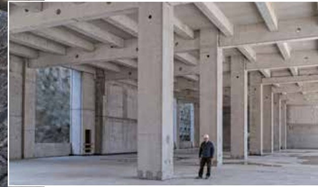
Karsten Klein im 1. OG des neuen Abfüllgebäudes
