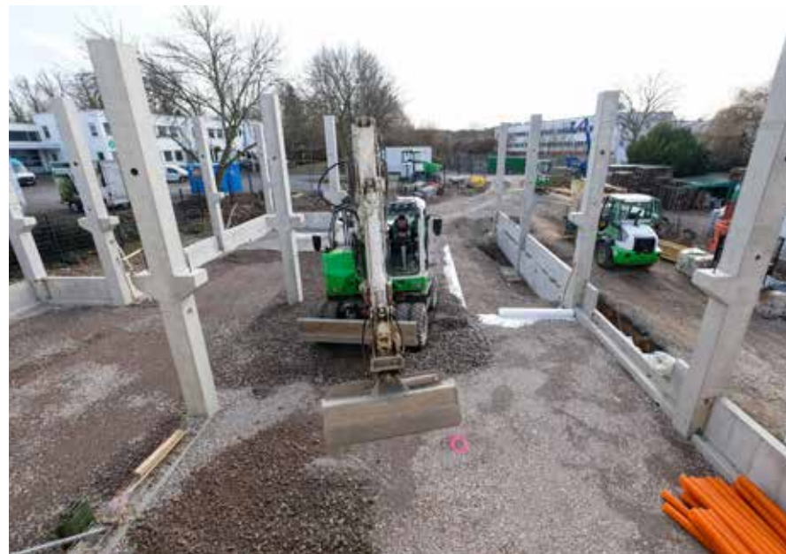
Die Fertigteilstützen und Sockelplatten für den Anbau sind montiert, das Schotterplanum wird erstellt.
