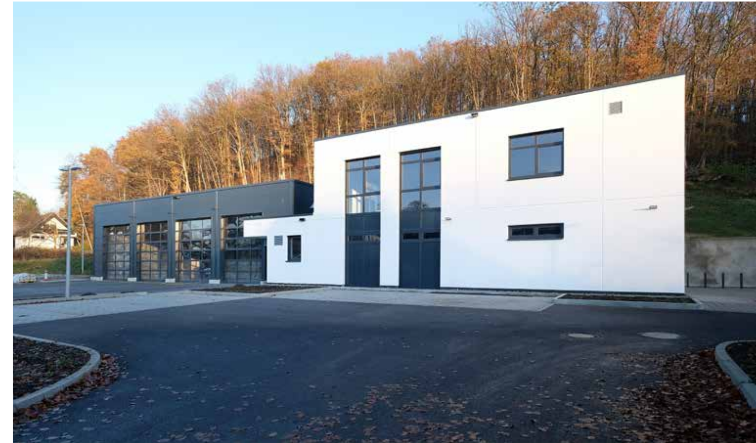
Das zweigeschossige Sozialgebäude mit angegliederter Fahrzeughalle
