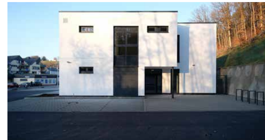
Eingang zu dem 475 m 2 großen Sozialgebäude
