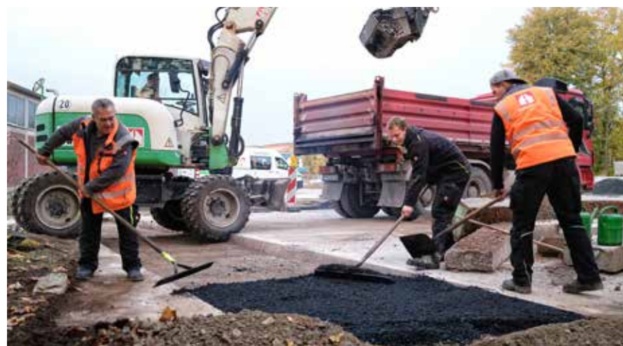
Die Straßenquerung beim Tankplatz und dem Salzsilo wird per Handeinbau asphaltiert.
