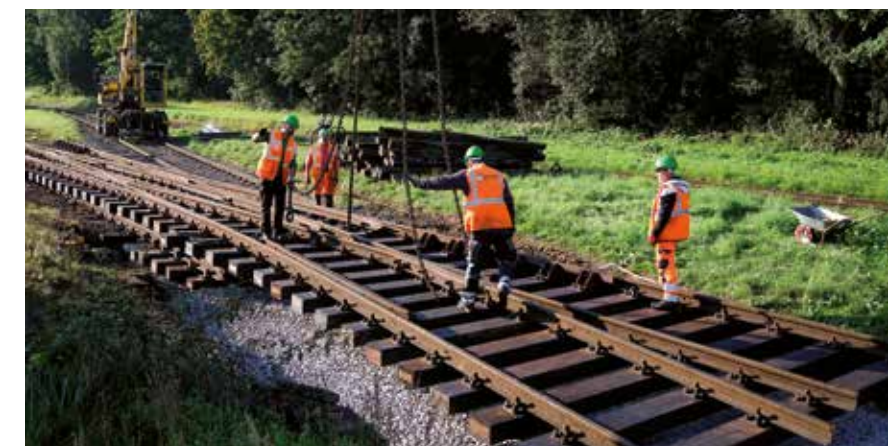
Die neue Weiche wird mit einem Autokran auf das neue Schotterbett gelegt.
