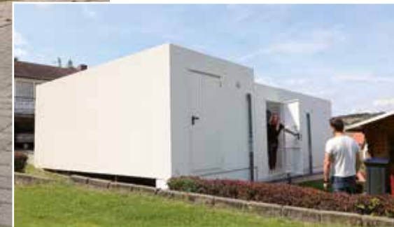
Die Garagenzugänge erfolgen über das dahinter liegende Grundstück.
