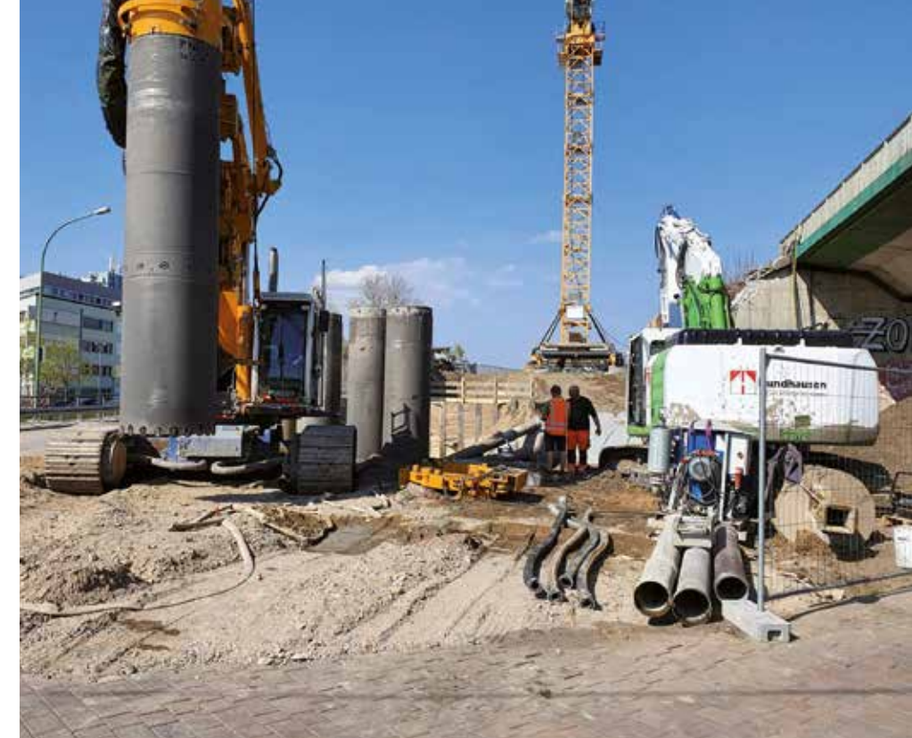
Die Bohrpfähle für den ersten Bauabschnitt an der Achse 80 in Potsdam werden hergestellt.
