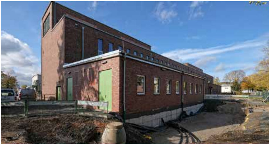
Fertigstellung des neuen Technikgebäudes als Anbau an das Bestandsgebäude
