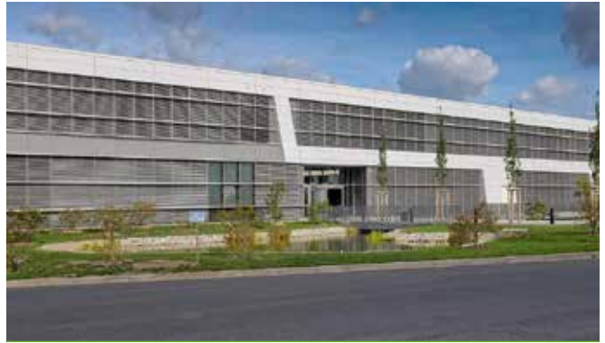
Produktionshalle und Verwaltungsgebäude für Geberit in Langenfeld, Seite 4-5
