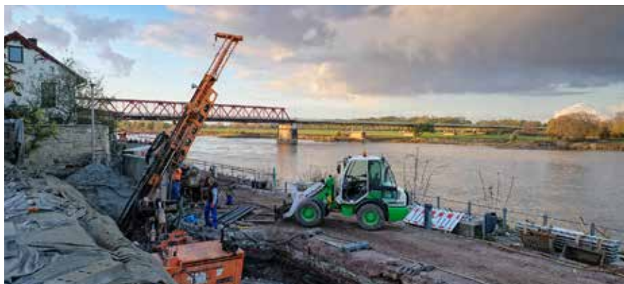
Verpressarbeiten am Teilobjekt 1
