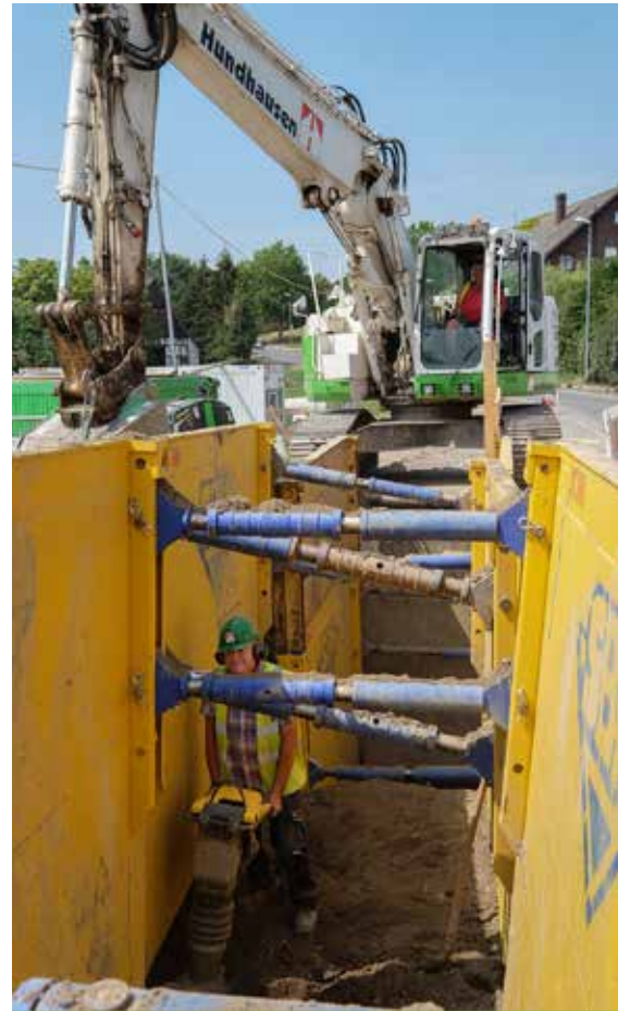
Blick in den verbauten Kanalgraben
