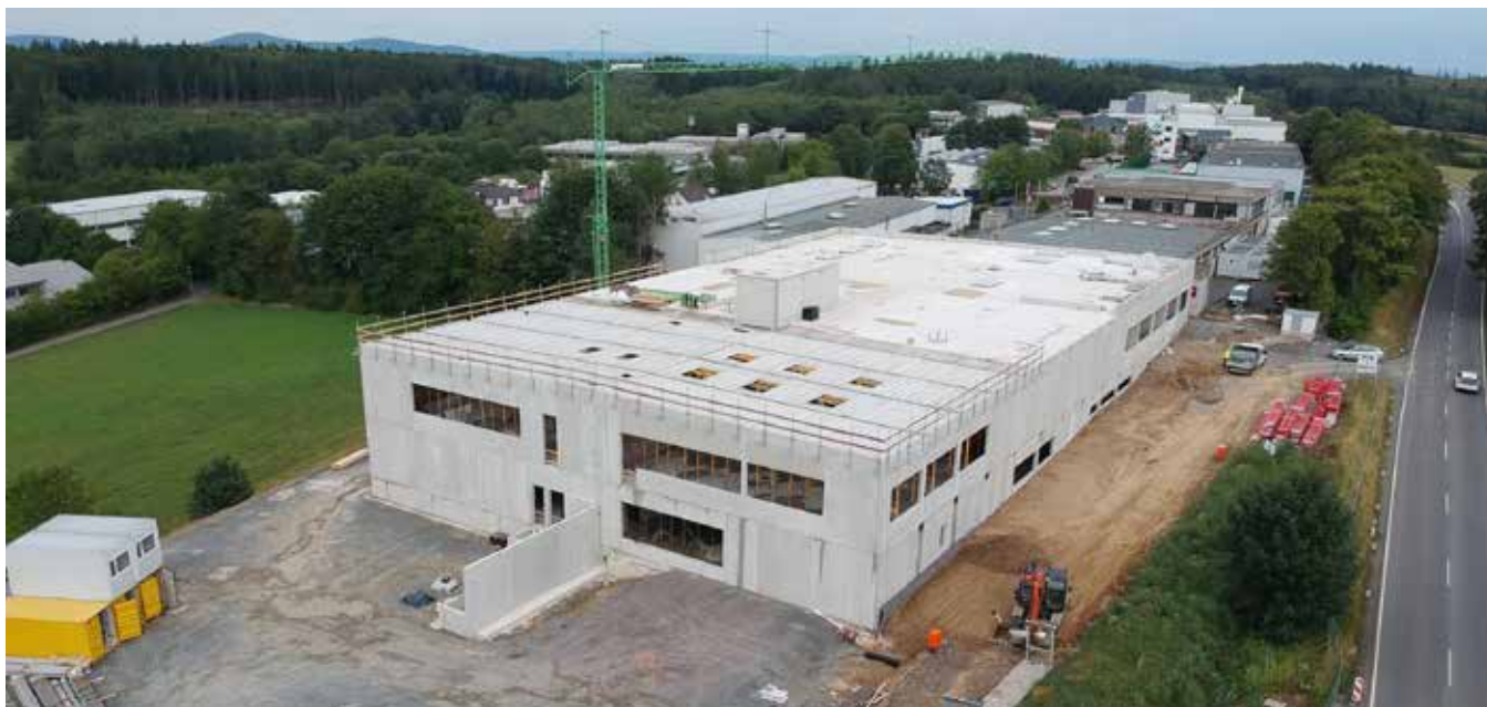
Drohnaufnahme des Rohbaus der neuen Frischeküche und des neuen Wurstbetriebes
