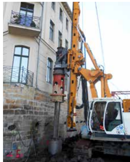
Bohrpfahlarbeiten am Teilobjekt 6
