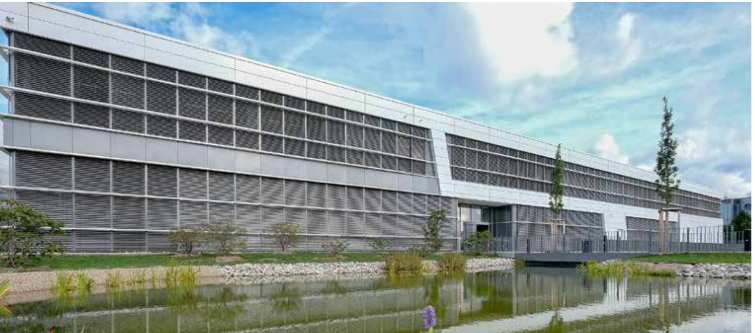
Blick auf das Bürogebäude inklusive einer Teichanlage, die zur Regenrückhaltung dient
