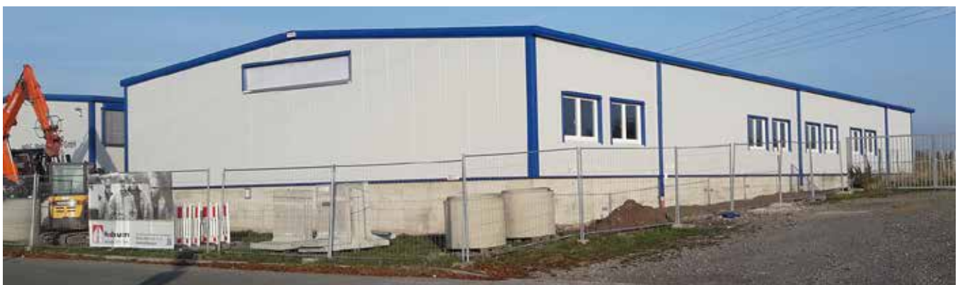
Erweiterungsbau der Fertigungshalle der WOLF-Medizintechnik GmbH in St. Gangloff
