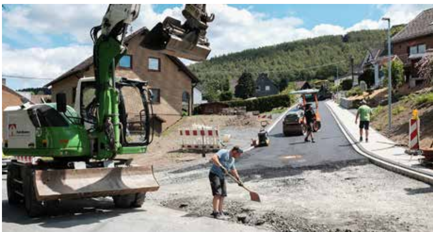
Die letzten Arbeiten zum Einbau der Asphaltfahrbahn werden getroffen.
