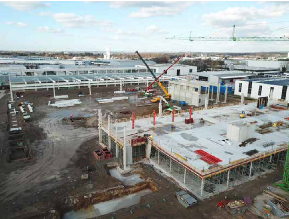
Drohenaufnahme vom Rohbau des Bürogebäudes und dem Stahlbau der Produktionshalle
