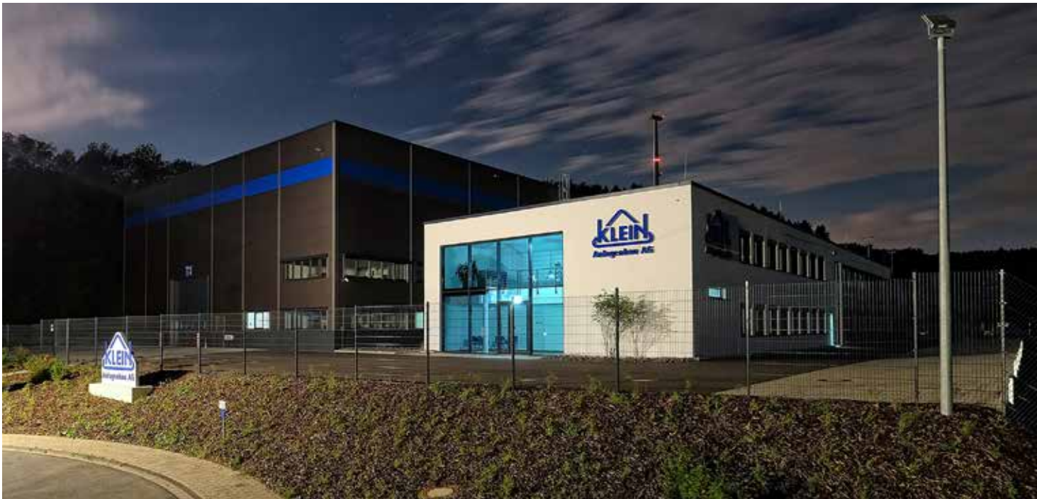
Nachtaufnahme des Produktions- und Verwaltungsgebäudes der Klein AG
