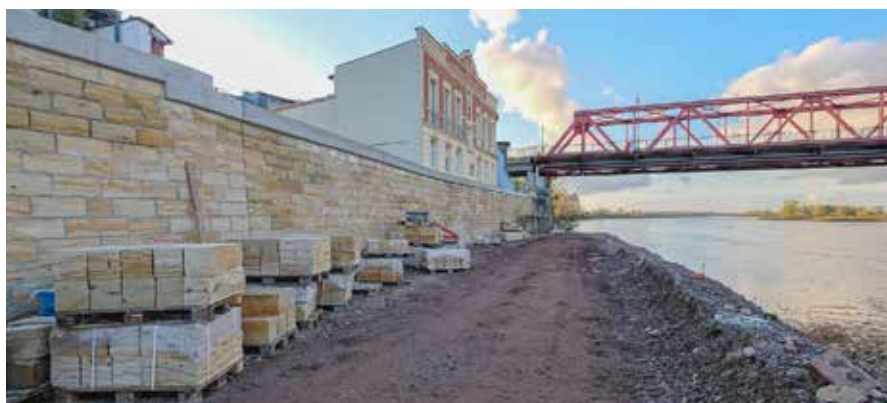
Fertiggestellte Hochwasserschutzwand mit Sandsteinverblendung am Teilobjekt 6
