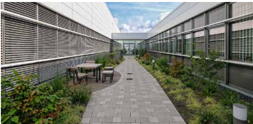
Einer von insgesamt drei Dachgärten inklusive eingebauter Leckageortung
