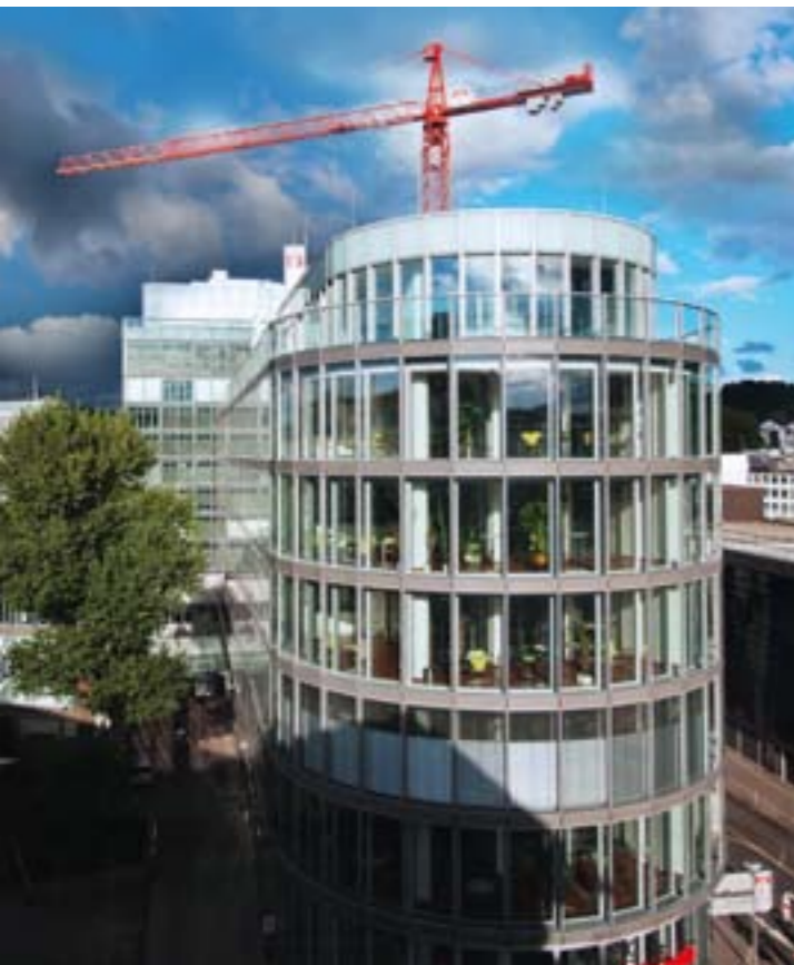
▲ Der Kran über den Dächern der Unterstadt
