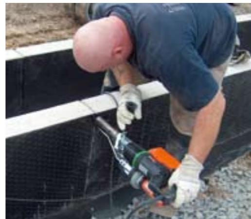
▲ Verschweißen der HDPE-Inlinerplatten an der Entwässerungsrinne
