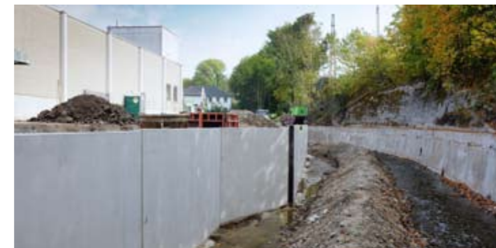
▼ Links: Betonstützwand aus unserem Fertigteilewerk in Eisern; rechts: alte Ort betonwand
