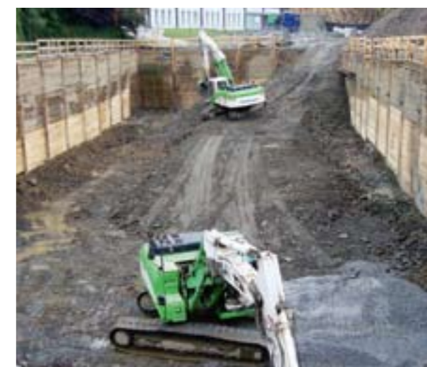
Die Baugrube ist fast fertig gestellt. Vorne: Einbringen der Drainageschicht in Beckenvertiefung; hinten: Restaushub des RÜB.
