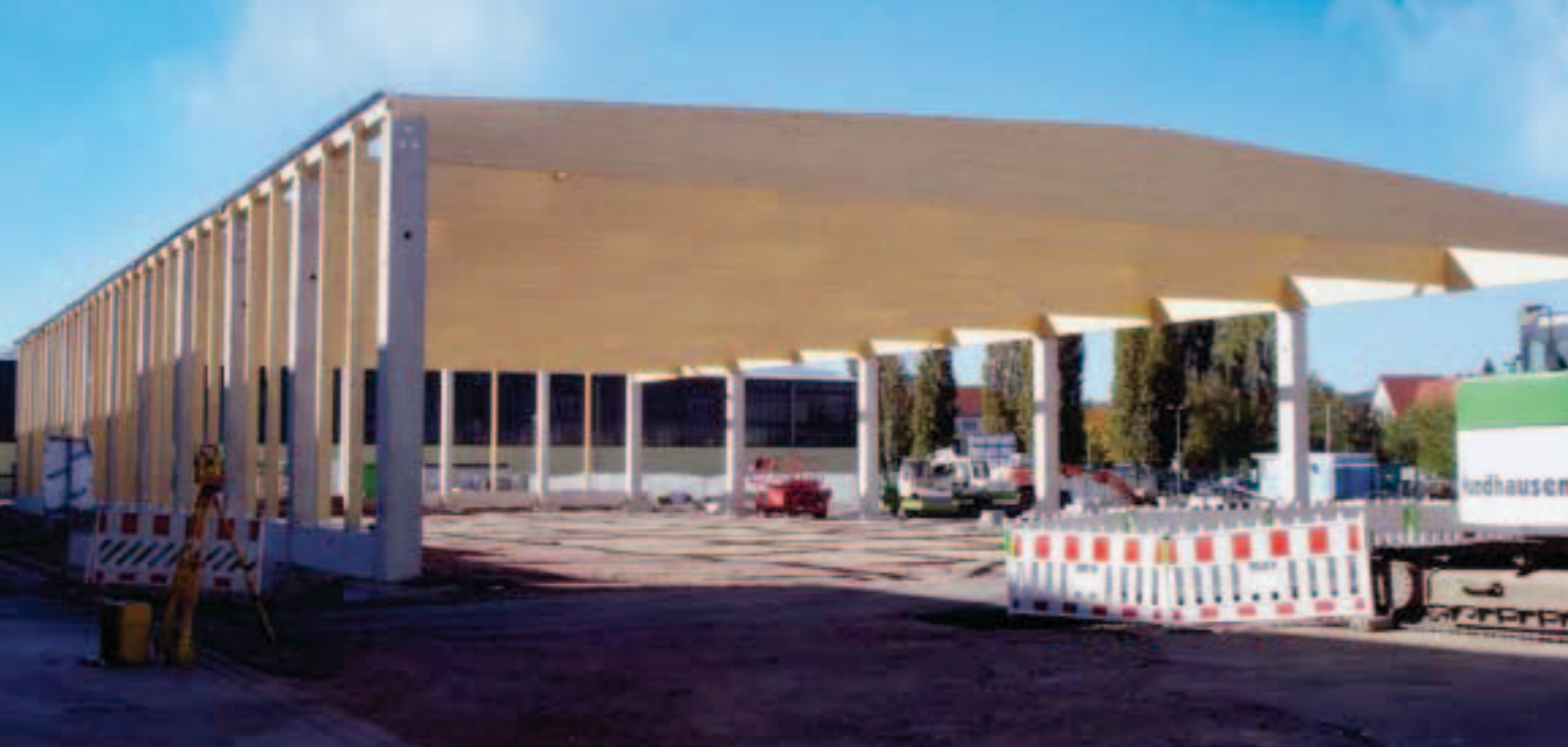
▲ Leerguthalle mit Leimholzbindern über 30 m Spannweite
