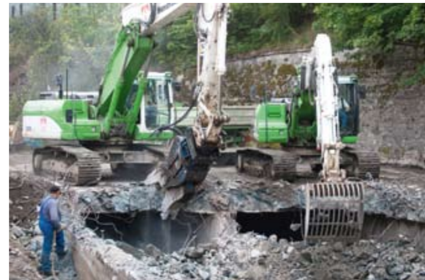
▲ Der Abbruch der Betonkastenprofile mit schwerem Gerät
