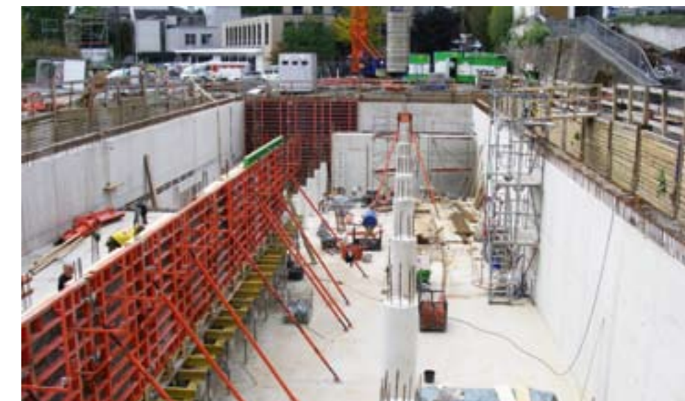
Die Baugrube ist fast fertig gestellt. Vorne: Einbringen der Drainageschicht in Beckenvertiefung; hinten: Restaushub des RÜB.
