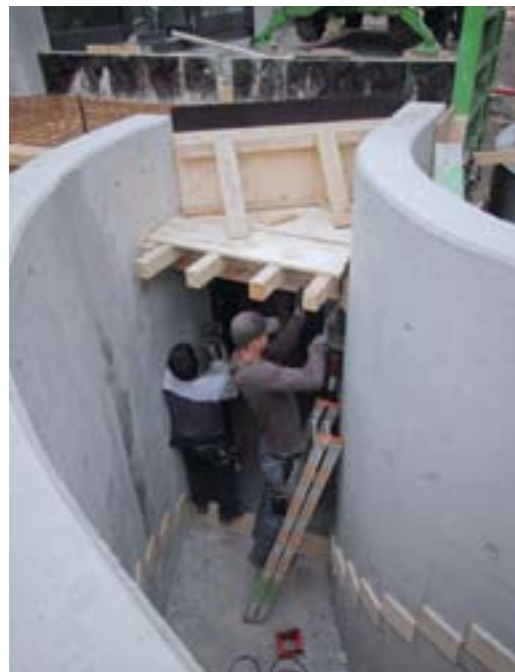
Iskender Asan und Kevin Zothe, beide Azubis Beton- und Stahlbetonbau, beim Schalen der Treppe
