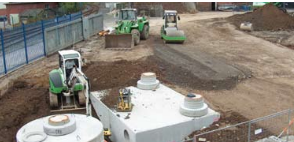
▼ Teilansicht der Baustelle
