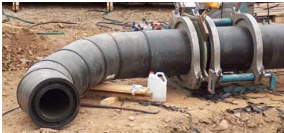
▲ Verschweißen eines HDPE-Doppelrohrbogens
