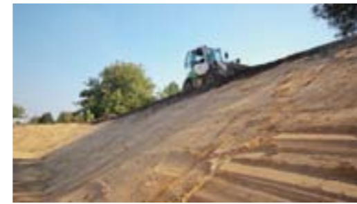
▼ Herstellung des umlaufenden Betriebsweges
