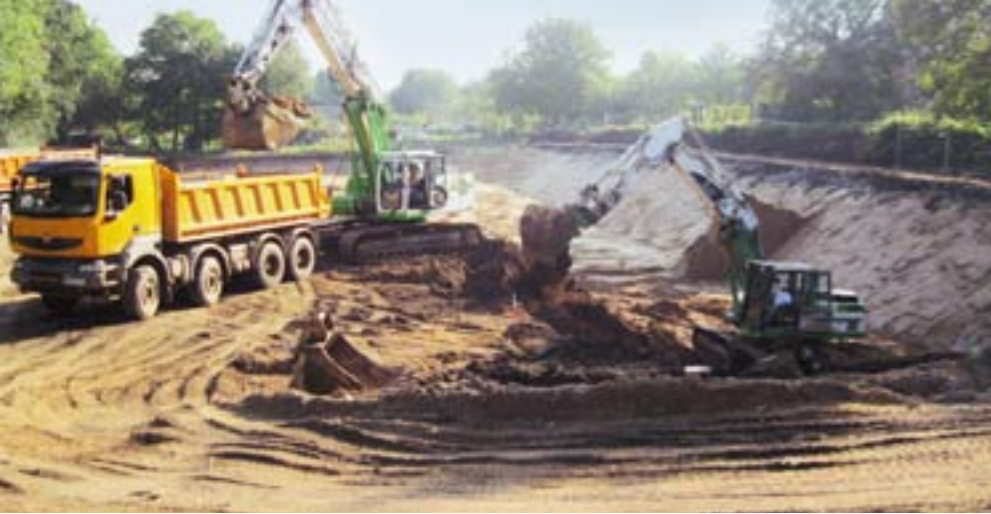
◀ Juri Ponomarenko und Heiner Fürst beim Bodenaushub des Beckens
