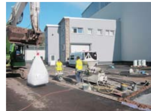
Einbau der Densiphalt-Decke für hochbeanspruchte Verkehrsflächen
