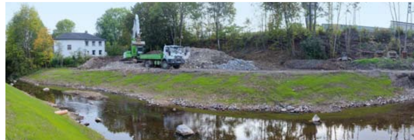
▼ Oberer Teil des fertig gestellten Gewässerausbaus
