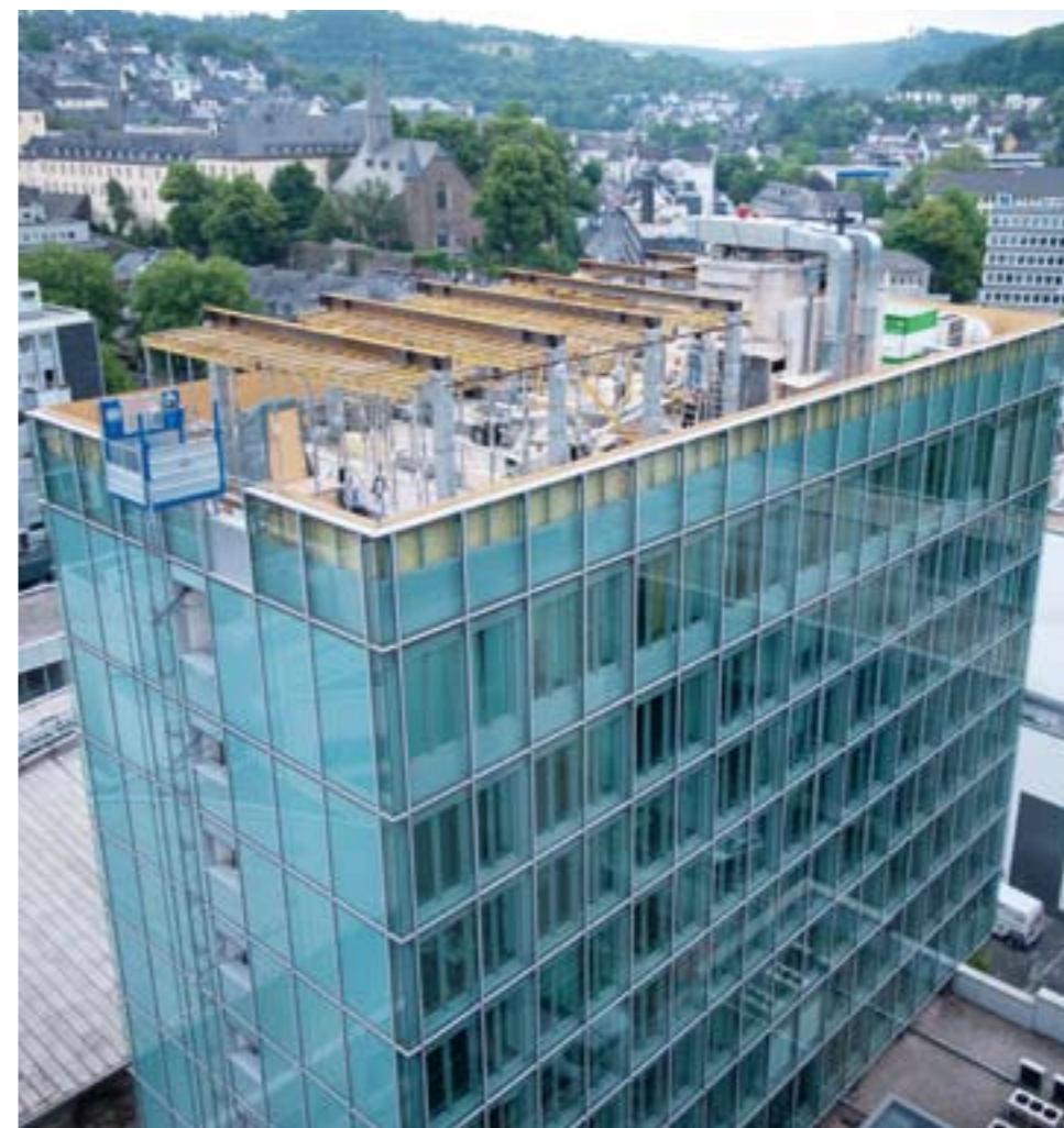
▼ Rohbau in luftiger Höhe (links ist der Baupersonenaufzug zu sehen)
