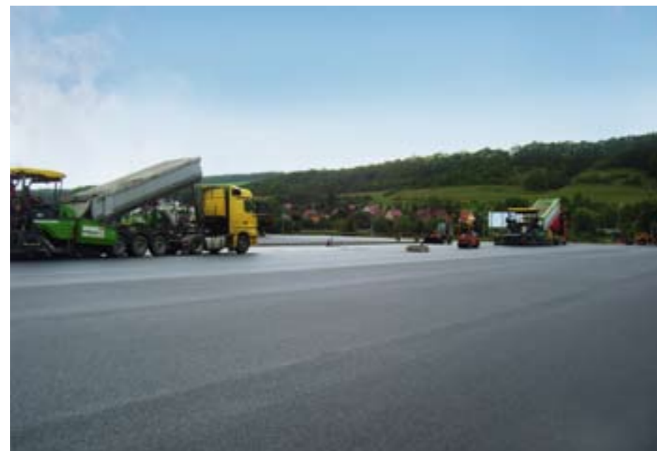
▼ Die kurze Bauzeit erforderte den gleichzeitigen Einsatz von zwei Asphaltfertigern
