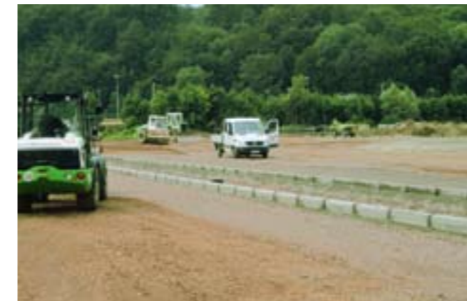
▼ Vor Beginn der Asphaltarbeiten sind die Randbefestigungen fast fertig gestellt
