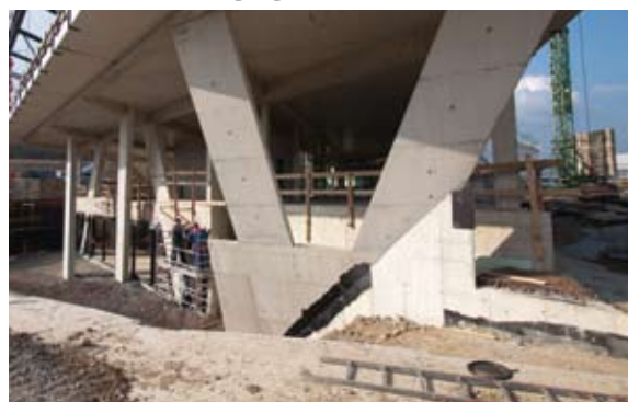
▼ V-Stütze am Abgang zum Tiefhof
