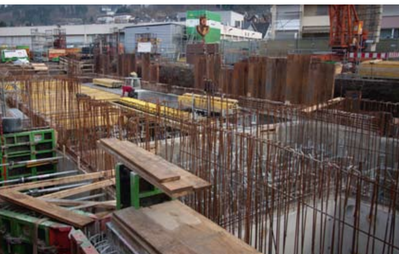
▲ Beginn der Deckenschalung beim Regenüberlaufbecken (RÜB)
