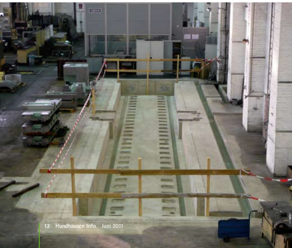
◀ Das Fundament für die Herkules-Fräsmaschine ist fertiggestellt.
