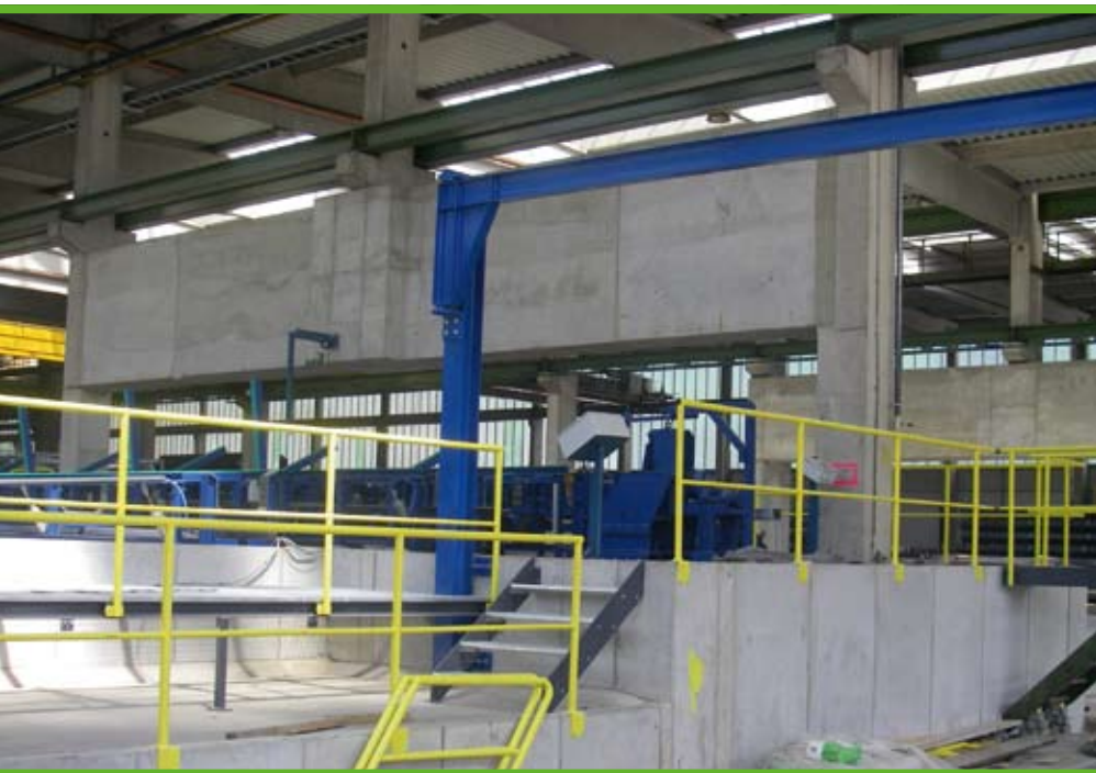
Fertiggestellte Abfangkonstruktion für Hallenstützen und Hallenkran ▲
