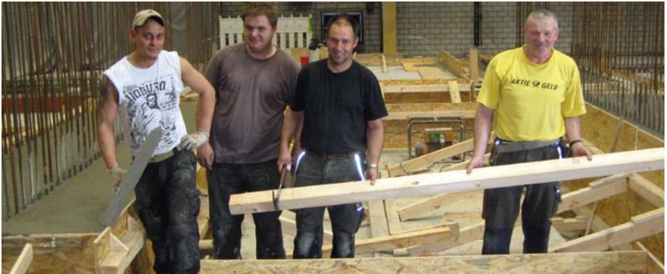
▲ Stahlbetonfacharbeiter aus Weida bei Schalarbeiten (v.l.: Stefan Steinbrich, Benjamin Schneider, Matthias Häckel, Jürgen Otto)
