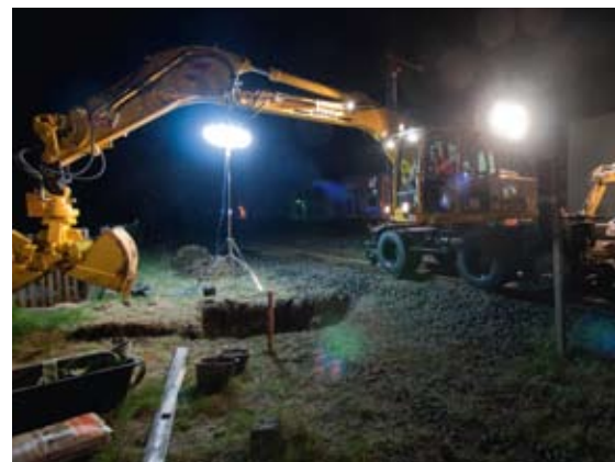
▲ Herstellung einer Rohrquerung im Gleisbereich
