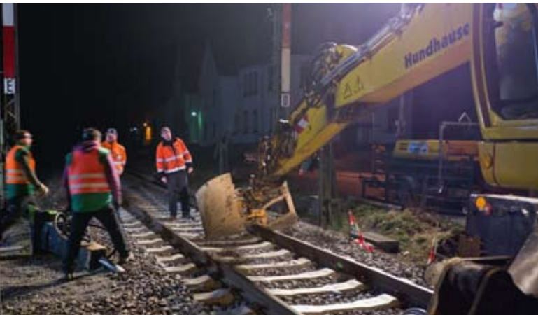
▲ Umbau von Greifer auf Abbruchhammer
