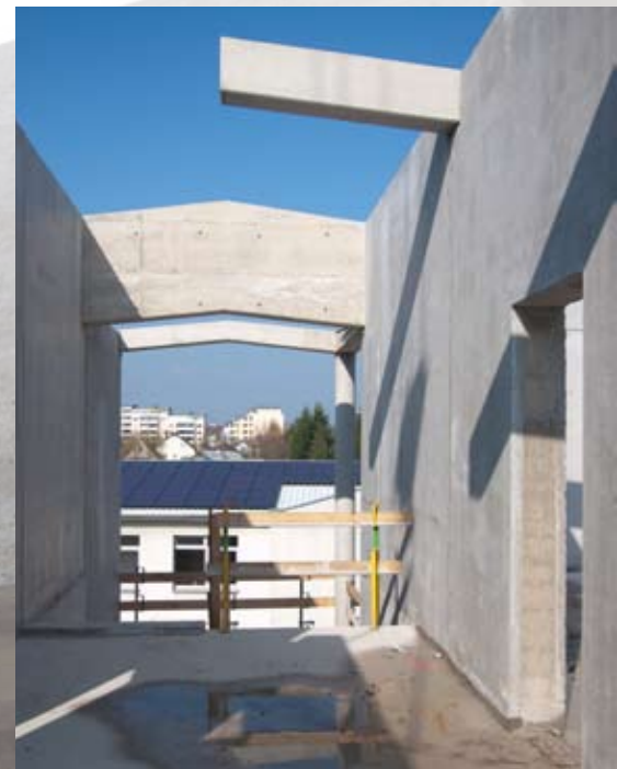
▲ Aussicht aus dem Flur im zweiten Obergeschoss
