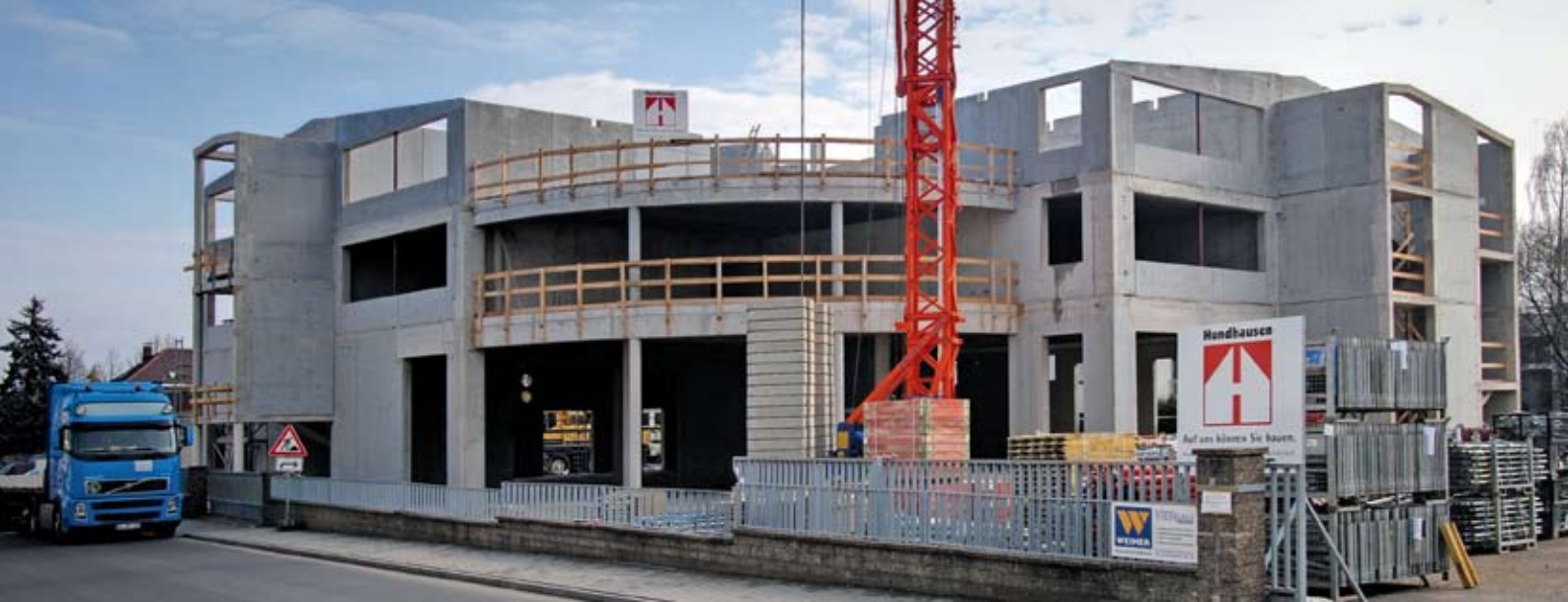
▲ Das neue Schulgebäude am Klingelbachweg im Rohbau
