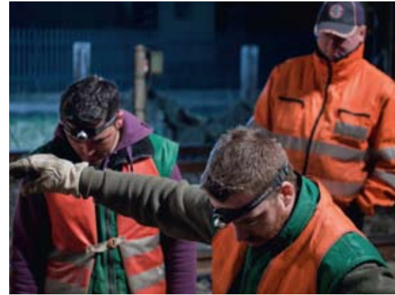
▲ Einweisung des Zwei-Wege-Baggers beim Setzen eines Kabelschachtes (v.l.: die Gleisbauer Besart Ferizi und Manuel Weber mit dem Arbeitszugführer)
