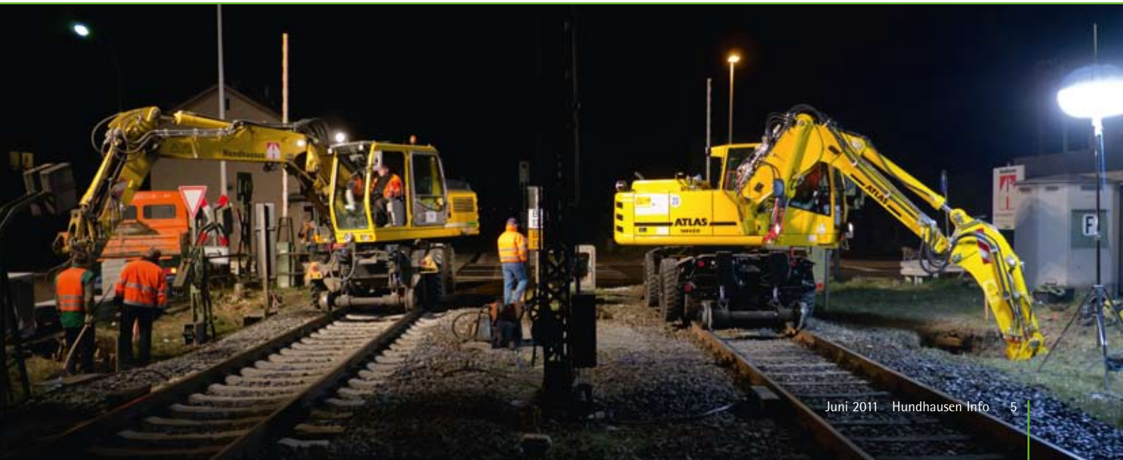
▼ Ausschachtungsarbeiten für den Einbau von Kabelschächten in der nächtlichen Sperrpause
