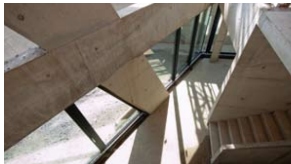
▼ V-Stütze am Abgang zum Tiefhof
