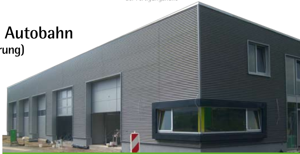
▲ Der Stützpunkt mit hinterlüfteter Alu-Fassade kurz vor der Fertigstellung
