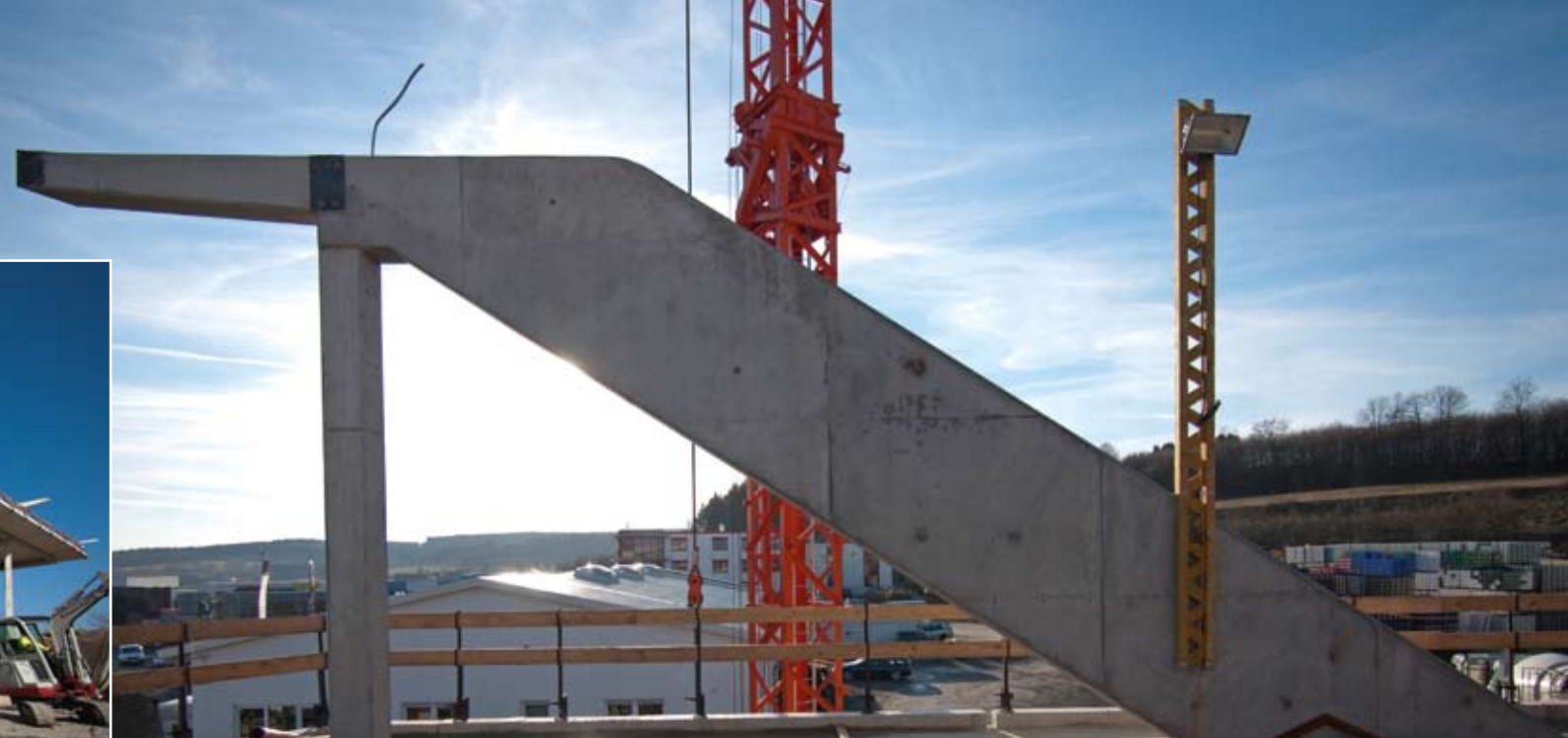
▲ Fassadenbügel an der Westseite
