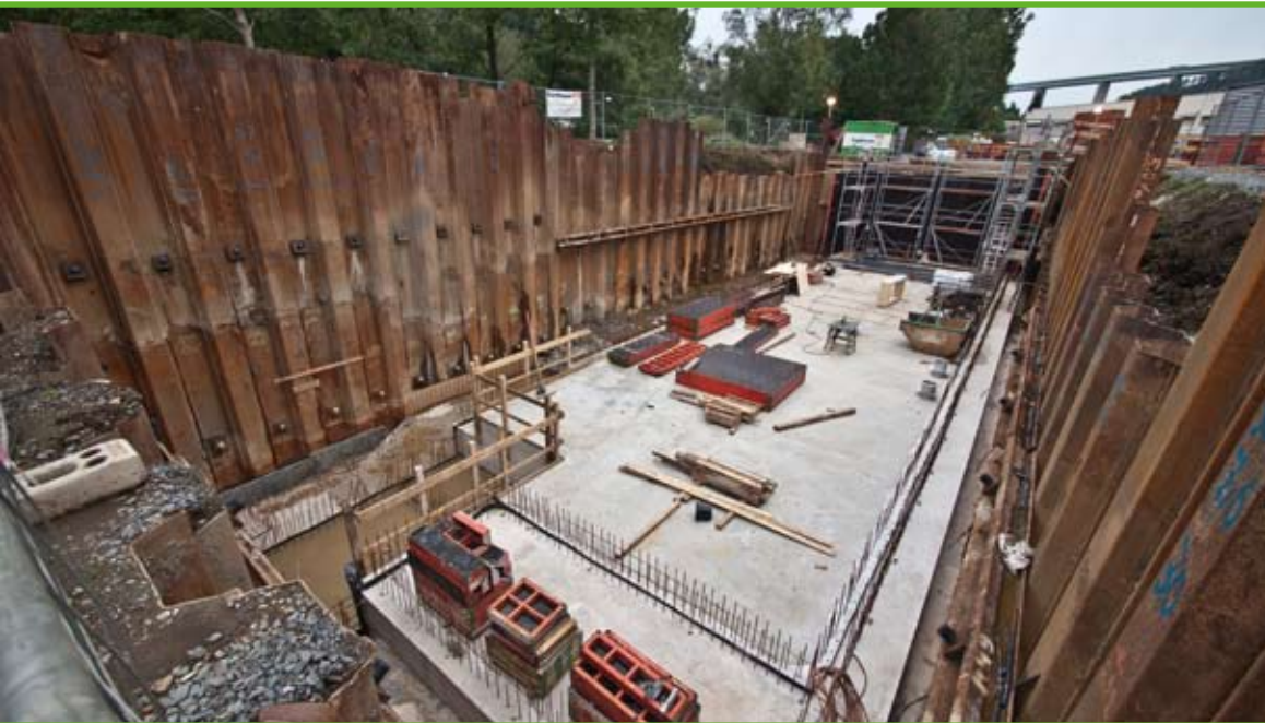
▲ 8 Meter tiefe Baugrube des RÜB mit zweifach rückverankerter Spundwand und fertiger Bodenplatte
