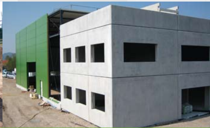
▲ Vorne die Fertigteilkonstruktion des Sozial- und Verwaltungstraktes, im Hintergrund die Stahlkonstruktion der Fertigungshalle
